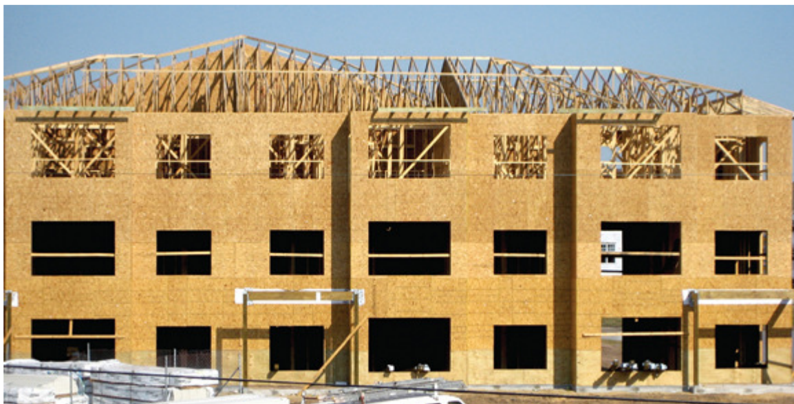
Nos EUA, sistema é utilizado para construção de prédios de até cinco pavimentos
