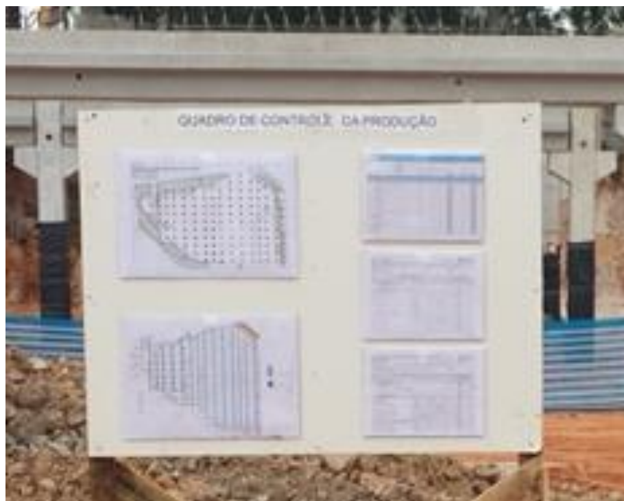
Figura 4.23 –Quadro de Controle da Produção na frente de serviço
