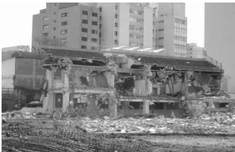
Figura 6. Aspecto da arquibancada após operação de desmonte. Fonte: Os Autores
