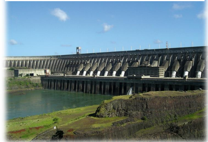
Itaipu (20 Vertical Francis 700 MW –118 m)
