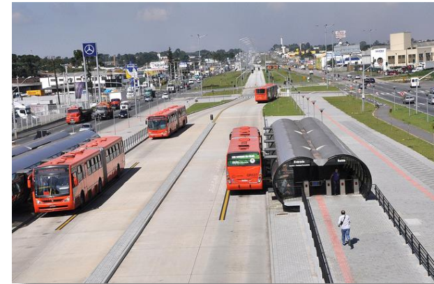
FONTE: The CityFix Brasil – WRI Brasil http://thecityfixbrasil.com/2012/06/04/novo-site-monitora-obras-de-sistemas-brt-no-brasil/
