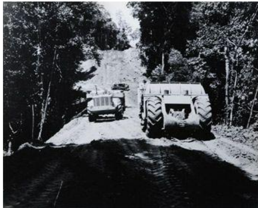
Obras da Rodovia Belém-Brasília FONTE: https://br.pinterest.com/pin/295830269243878531/
