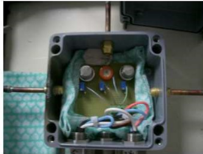
Figura 12 - Montagem dos sensores.
