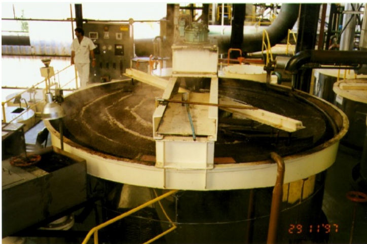
Clarificador da Refinadora Catarinense (Açúcar Portobelo) - Ilhota / SC
