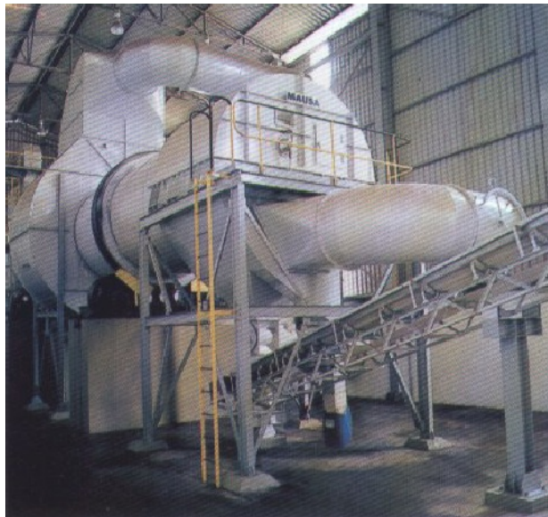
Secador Horizontal Rotativo, descarregando açúcar seco para o armazenamento
