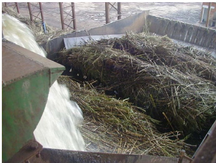
Mesa alimentadora automatizada – Usina Alcoazul – CLP LC700 SMAR
