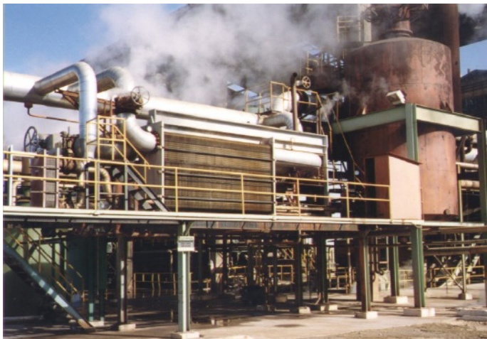
Evaporador à placas
