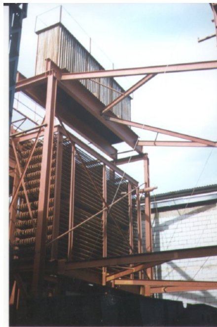
Pré-Aquecedor de Ar e Economizador (Em fase de montagem)
