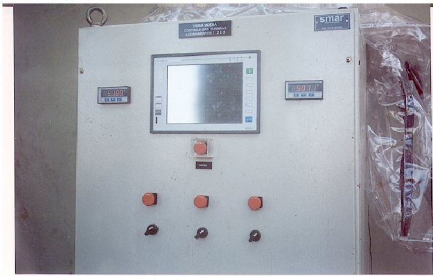
Painel Inteligente de Turbina dos ternos da Moenda – Usina Moema – CLP LC700 SMAR
