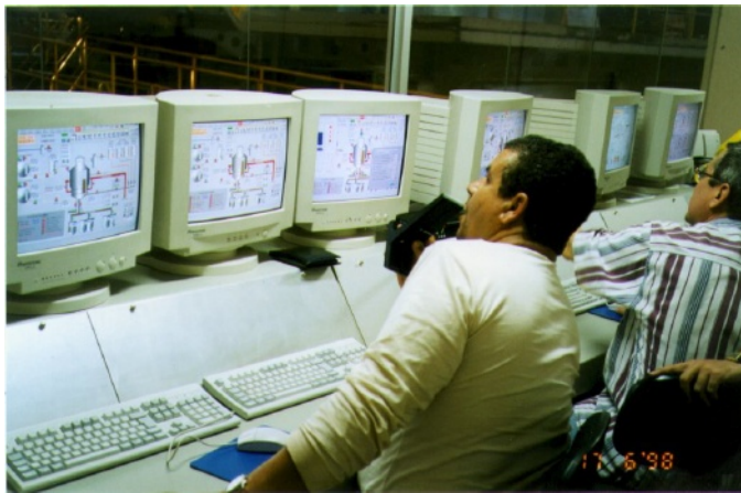
Sala de operação dos Cozedores - Usina Santa Elisa
