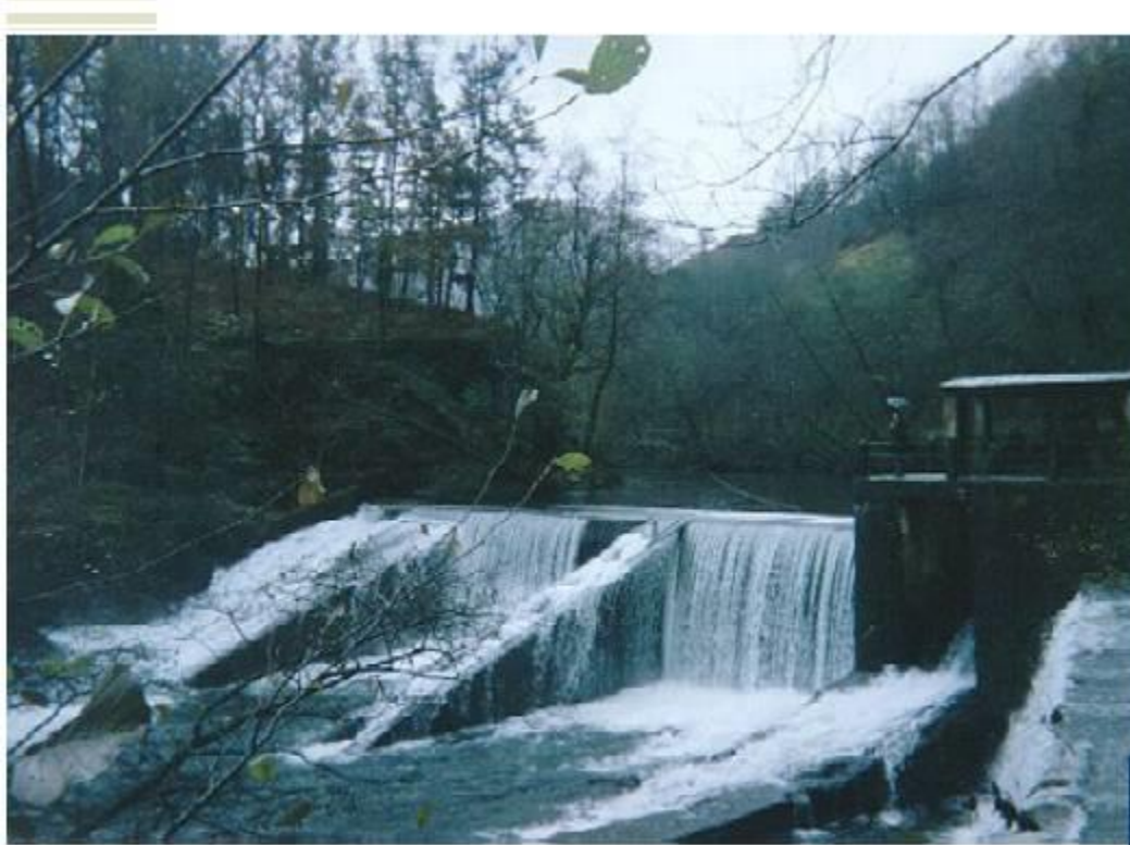
Queda de 89,23 m, vazão de projeto 6,75 m 3 /s turbinas Francis de 3 640 kW e 1 740 kW
