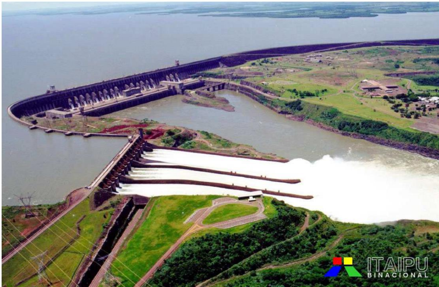
UHE Itaipu – PR, Rio Paraná (14.000 MW)
