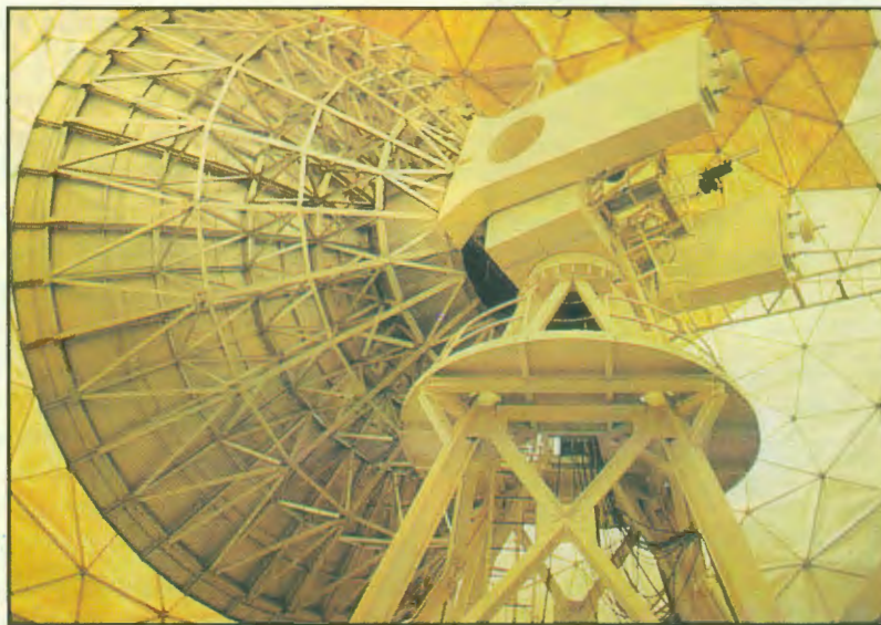
Interior da cúpula do Radiobservatório do Itapetinga, em Atibaia (SP)
