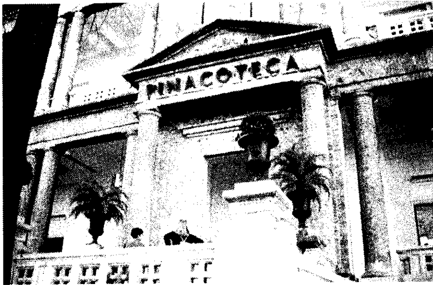
Pinacoteca de São Paulo, reformada por Paulo Mendes da Rocha, 1998 (detalhe da nova fachada e interior)
