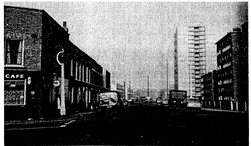
7.9 A Grande Reconstrução no East End
