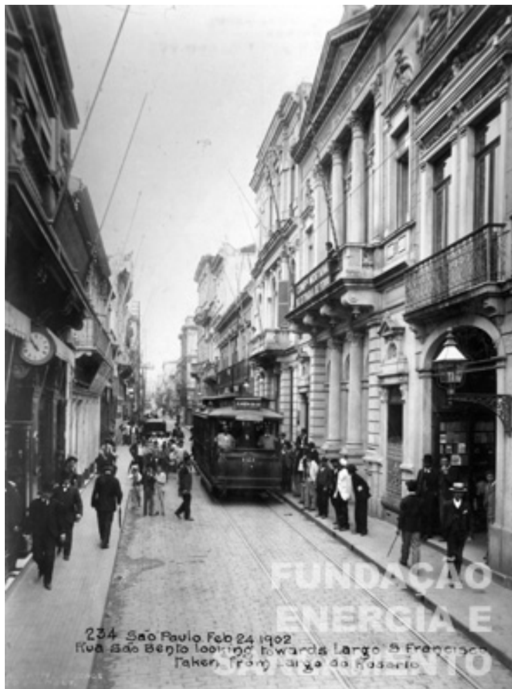
IMAGEM 485: Rua São Bento em direção ao Largo São Francisco, o terceiro edifício à direita, é o antigo número 61, o primeiro endereço do Hotel e Rôtisserie Sportsman. O segundo edifício à direita era o edifício da Companhia Mogiana de Estradas de Ferro. Foto de Guilherme Gaensly, em 1902. Acervo da Fundação Patrimônio Histórico da Energia e Saneamento de São Paulo.
