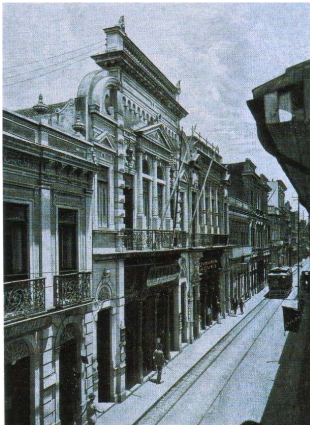
IMAGEM 464: Em primeiro plano, aparece parte da Loja da China e o vizinho é a Casa Nathan, com projeto de Max Hehl, construído em 1902. O lote seguinte é o atual Edifício LAMIA. In: Heloisa Barbuy. A Cidade Exposição . p.160.
