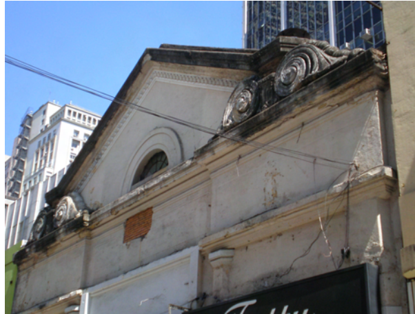
IMAGEM 462: Situação do edifício do Cine São Bento em 2007. Foto da autora.
