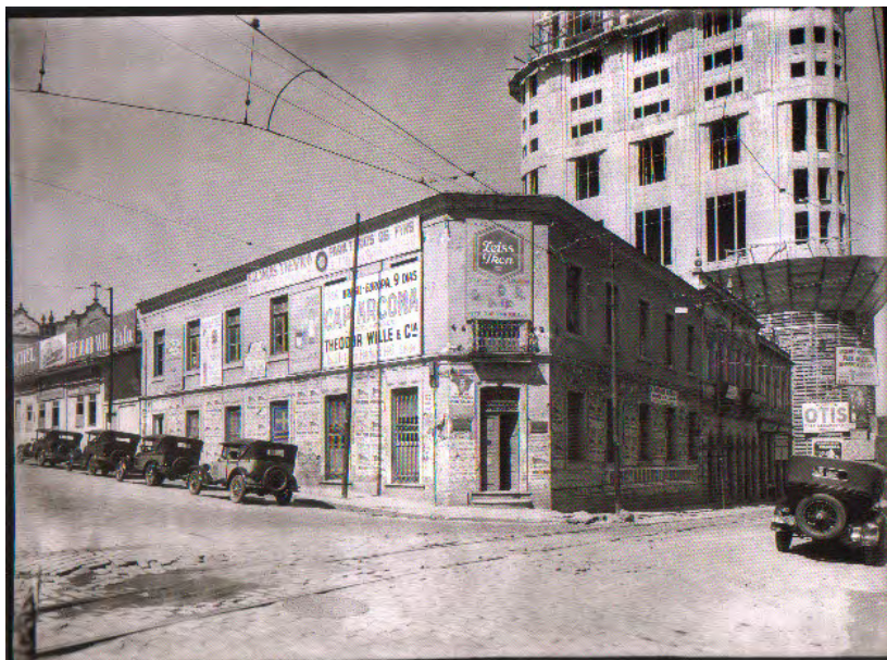
IMAGEM 75: Aos fundos em obras o Prédio Saldanha Marinho, em construção no final dos anos 20. In: JARDIM, Eduardo Carlos; MUSA, João Luiz; MENDES, Ricardo; São Paulo anos 20 andar, vagar, perder-se . p.135.
