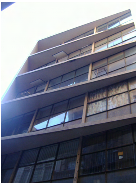
IMAGEM 465: Edifício LAMIA, em 2006.
