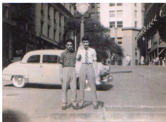
IMAGEM 489: Vista da Praça Antônio Prado, em 1957. Observar à direita o Edifício H. Lara em obras. Foto do acervo particular de Sebastião Martins Vieira.
