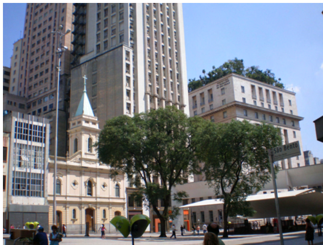
IMAGEM 191: Inserção da Igreja na Praça do Patriarca. À direita o pórtico, cobertura do acesso a Galeria Prestes Maia.
