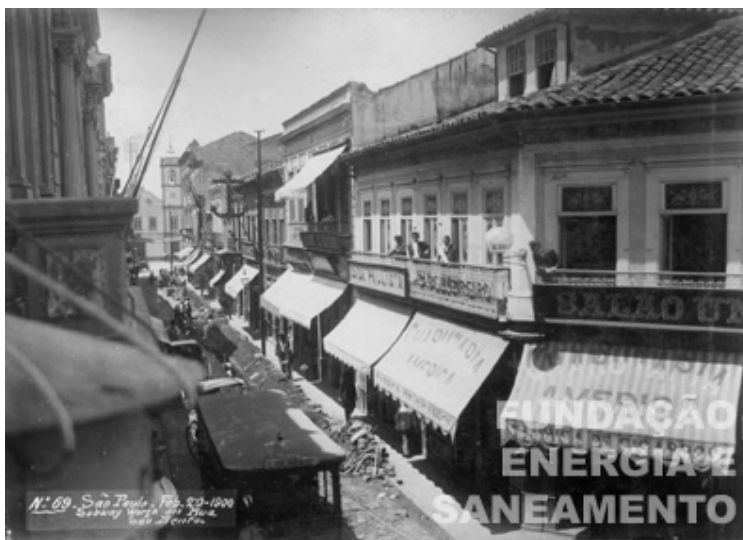
IMAGEM 511: Trecho do lado par da rua São Bento, entre a Avenida São João e o Largo São Bento, em 1900. Autoria desconhecida. Acervo da Fundação do Patrimônio Histórico da Energia e Saneamento de São Paulo.
