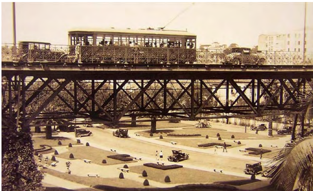
IMAGEM 80: Estrutura Metálica do Viaduto do Chá sobre o Parque do Anhangabaú em 1929. Cartão postal, coleção particular de Elíseo Belchior, In São Paulo Vila Cidade Metrôpole , de Nestor Goulart Reis Filho, p.153.
