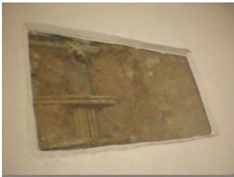
IMAGEM 189: Detalhe da Taipa deixado aparente após trecho restaurado.
