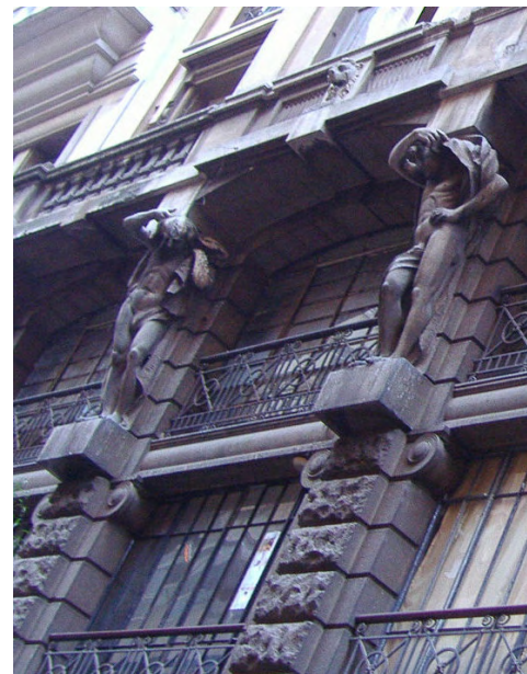
IMAGEM 479: Detalhe da fachada do Palacete Crespi, Edifício York. Foto da autora, 2007.
