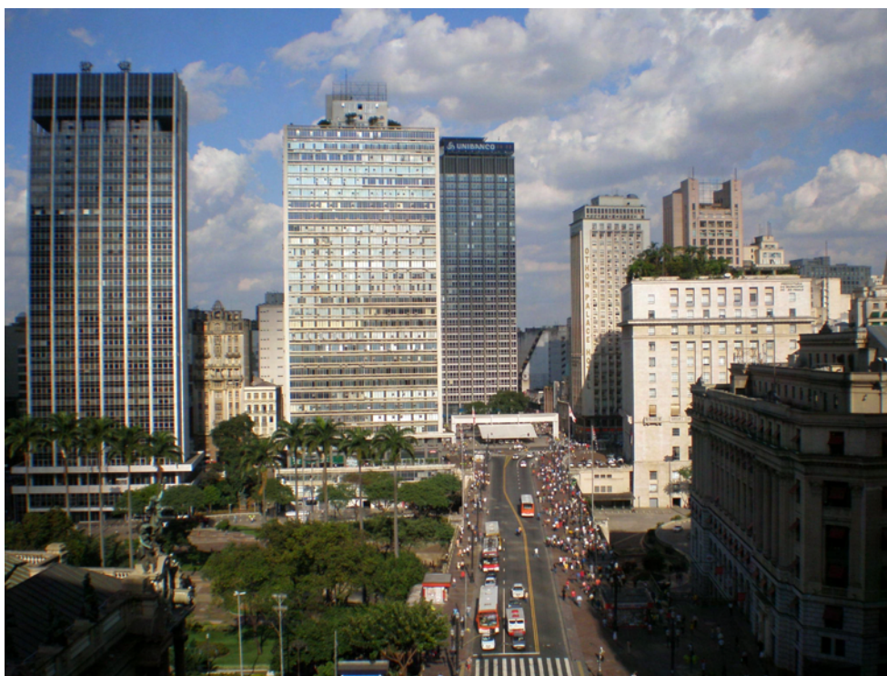
IMAGEM 104: Comparar o volume, a altura, gabarito dos edifícios com a imagem 103. Na Praça do Patriarca o Pórtico com a cobertura do acesso a Galeria Prestes Maia, projetado pelo arquiteto Paulo Mendes da Rocha.
