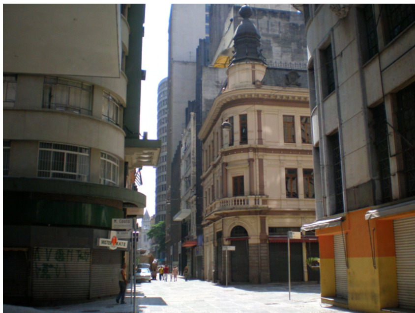
IMAGENS 96: Rua São Bento na altura do Largo do Café, em direção ao Largo São Bento. O Edifício na esquina é o anexo do Grande Hotel. Fotografia tirada em 2007.
