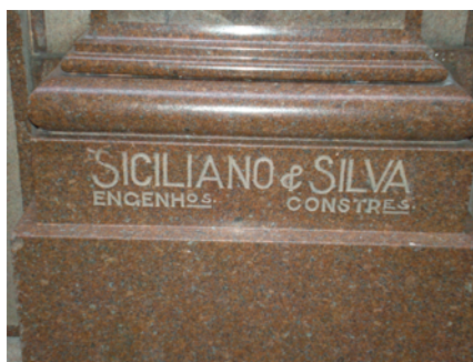
IMAGEM 484: Entalhe na fachada do Edifício Sant'Ana.
