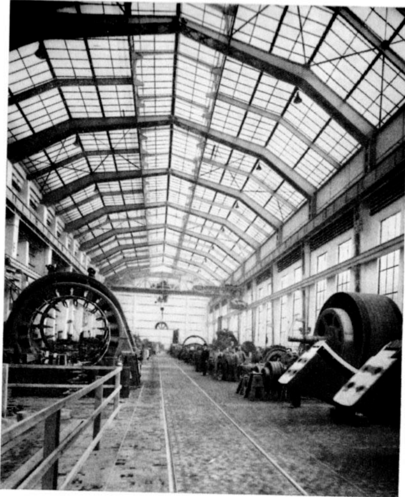
Peter Behrens. Berlín, 1911/12: nave de montaje de la AEG (luz, 30 m.).
