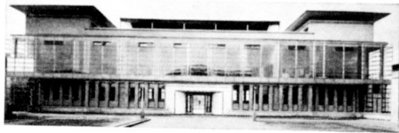
Walter Gropius y Adolf Meyer. Fábrica Fagus, desde 1911: nave de maquinaria.
