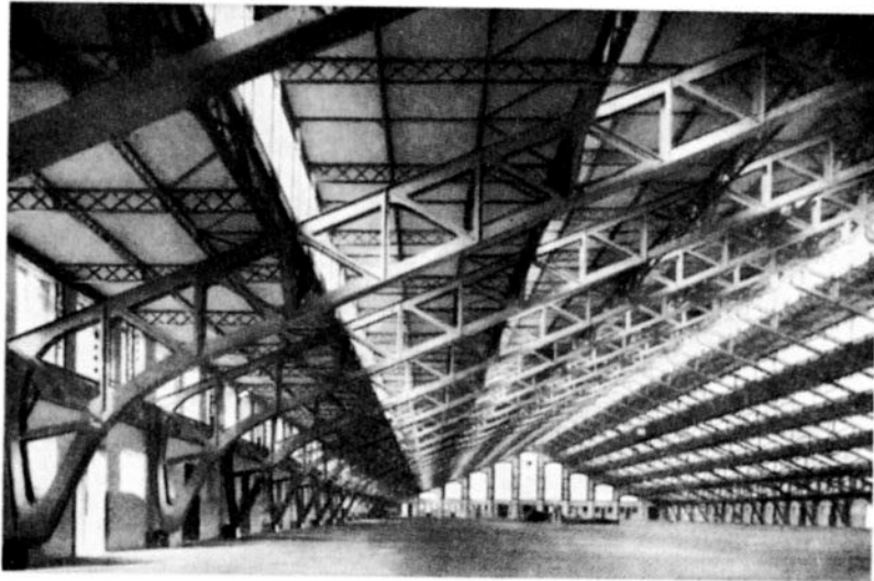
Tony Garnier. Lyon, 1915: nave del matadero (80 m. de luz, 210 m. de longitud)
