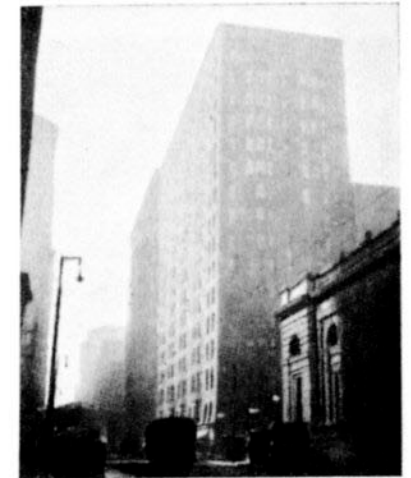
John Root: bloque Monadnock en Chicago, construido únicamente en ladrillo en 1891, sin estructura de acero.
