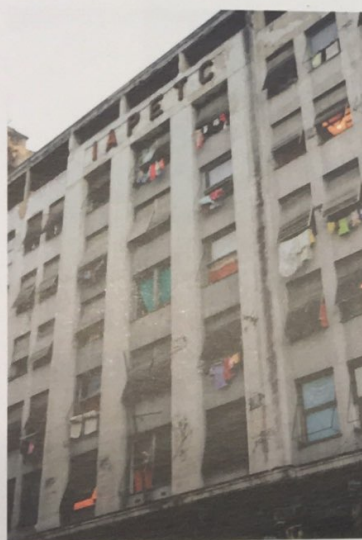
Edifício do INSS no Rio de Janeiro, originalmente pertencente ao IAPETC, ocupado pelo movimento de moradia, em foto de 2009. Apesar do generoso subsídio previsto no Programa Minha Casa Minha Vida, ele não foi desenhado para possibilitar a reabilitação de edifícios ociosos em áreas consolidadas, o que tem impedido ou dificultado o desenvolvimento de projetos desse tipo. Esse fato mostra como as ações habitacionais continuam desarticuladas da política urbana, pois a produção de moradias populares em locais próximos ao emprego é uma necessidade fundamental para melhorar as condições e o custo de mobilidade.
