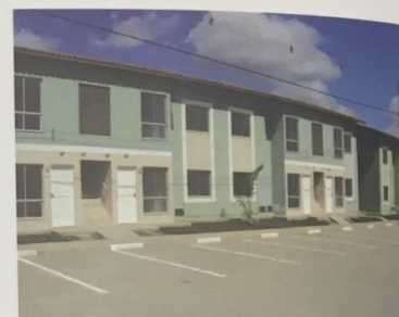
No alto, Jardim Mangueiral, empreendimento do PMCMV em construção em Brasília.
