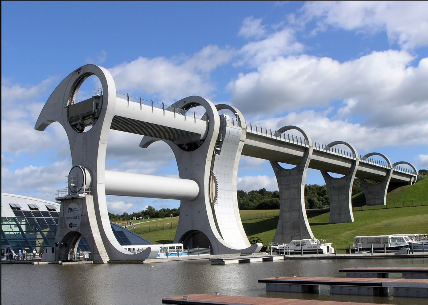
Navegação – Elevador de Barcos Escócia
