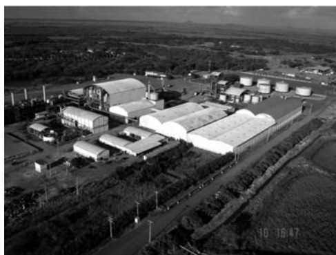
Unidade industrial da AgroVale no VSF
