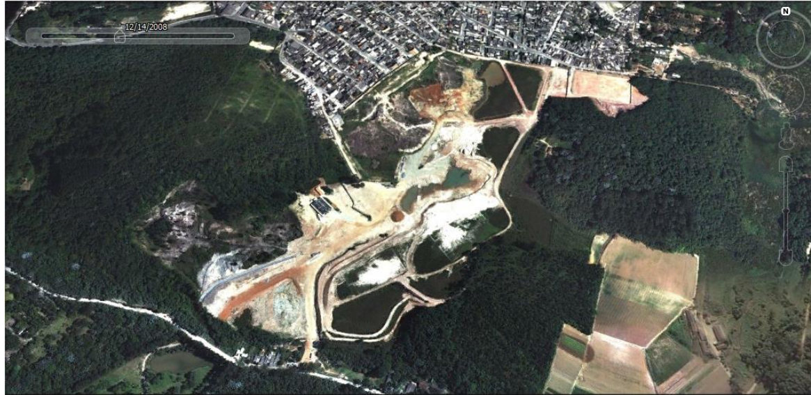
Grajaú em 2009 com cava de 30m de profundidade
