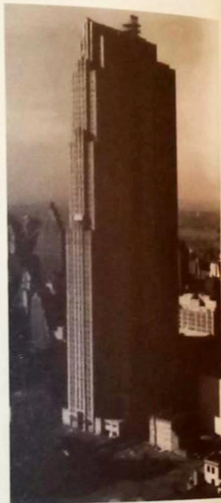
Rockefeller Center, em construção
