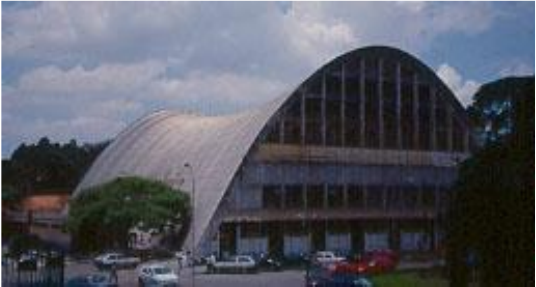
Piscina Coberta Centro Esportivo Baby Barioni - SP - 1948 Ícaro de Castro Mello
