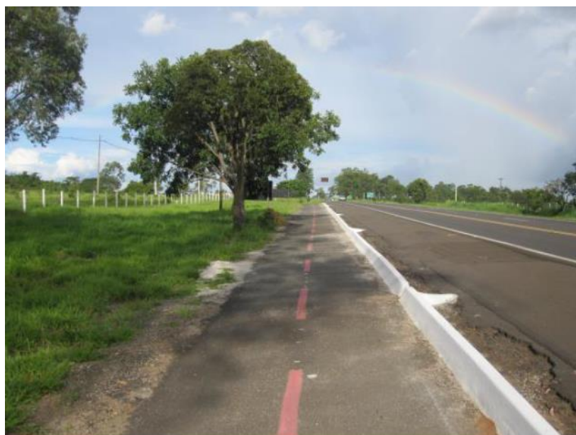
Figura 18 - Aspecto geral da ciclovia em trecho com guia separadora de acostamento. (VELÁZQUEZ, 2014, p. 117)
