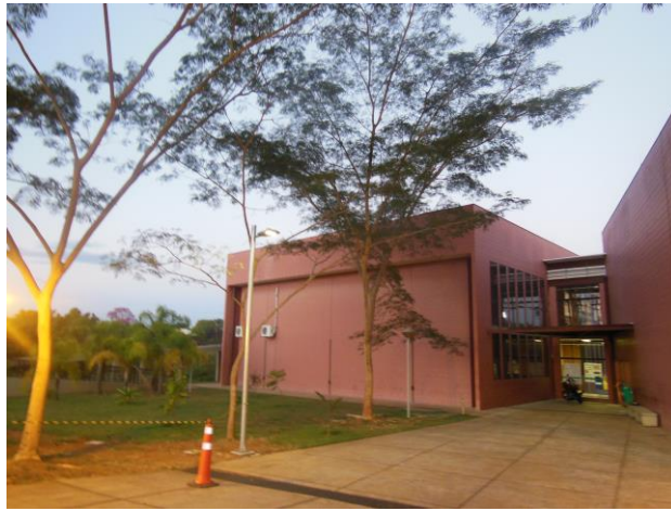
Figura 11. Prédio da Engenharia Ambiental
