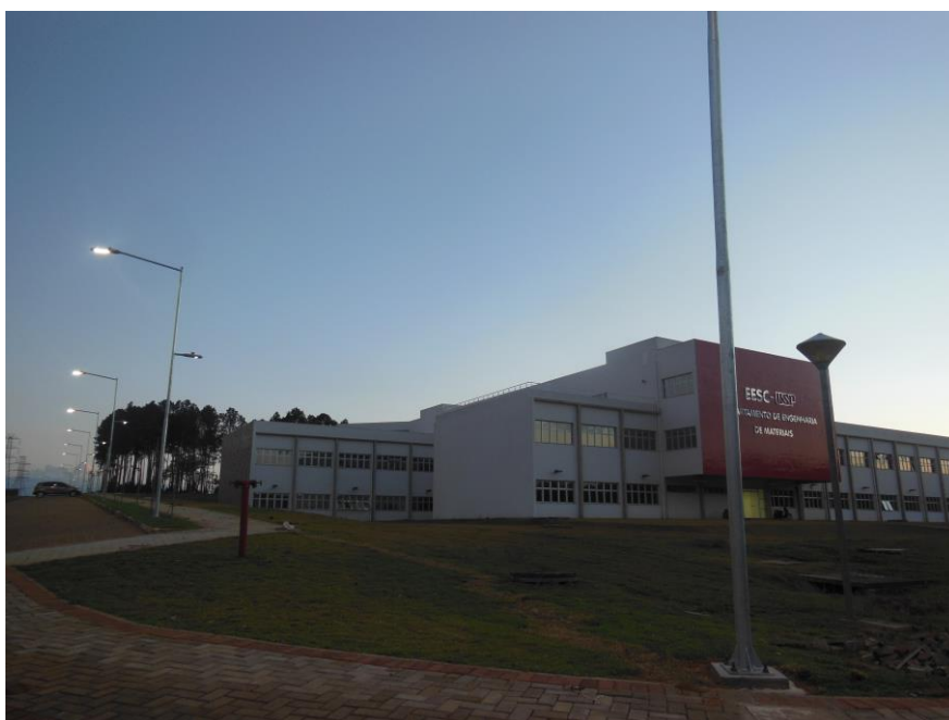
Figura 7. Engenharia de materiais sem arborização ao redor
