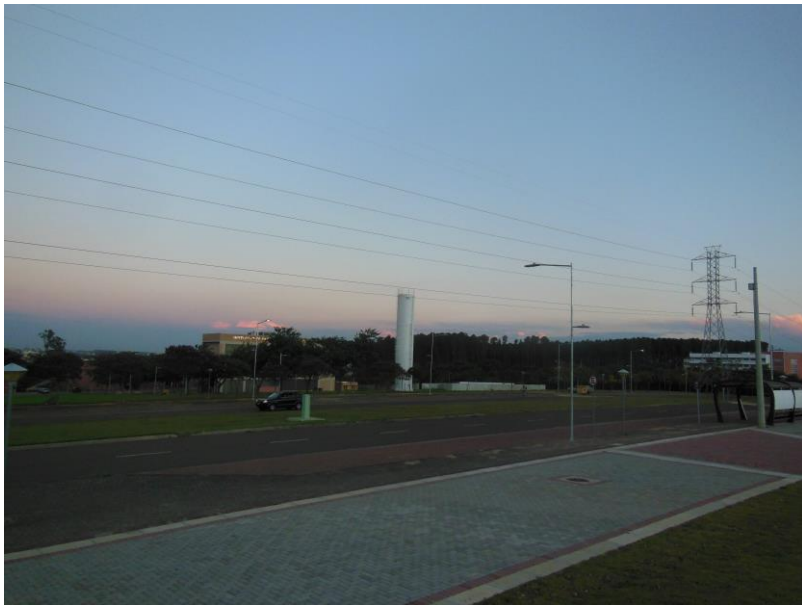
Figura 4. Linhão de energia
