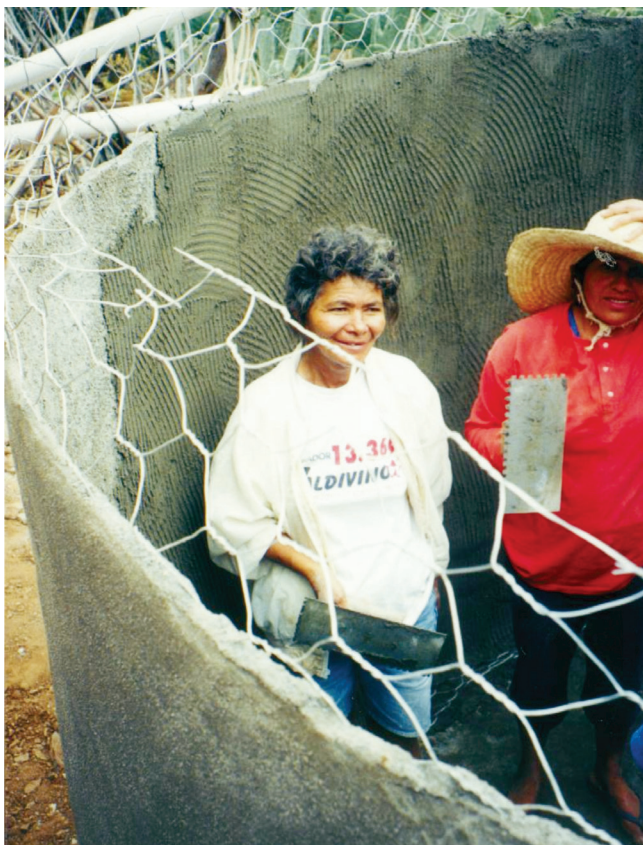
Figura 23. Construção de cisterna de concreto com tela de arame Foto: IRPAA
