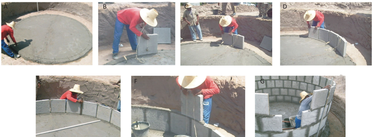
Figura 6. Levantamento das paredes: (A) marcação da posição das placas; (B) colocação da primeira placa; (C) e (D) colocação das placas subsequentes; (E) rejunte das placas com argamassa; (F) colocação da segunda fileira de placas; (G) rejunte das placas superiores
