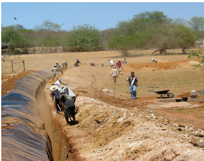
Figura 27. Barragem subterrânea, colocando a lona de PVC Foto: IRPAA
