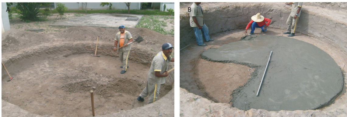
Figura 4. Base da cisterna: (A) escavação do buraco; (B) contrapiso
