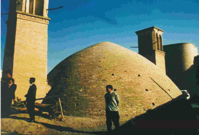
Figura 3 Abanbar, cisterna tradicional perto de Isfahan, Irã Foto: Gnadlinger
