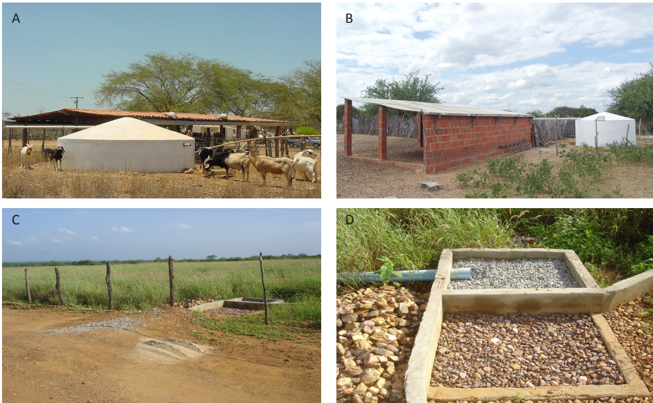
Figura 5. Cisternas de produção para atender aos caprinos e ovinos, instaladas no campo experimental da Embrapa (A), em área de produtor (B) e detalhes do sistema de filtragem (C) e bebedouro (D). Fotos: Nilton de Brito Cavalcanti.
