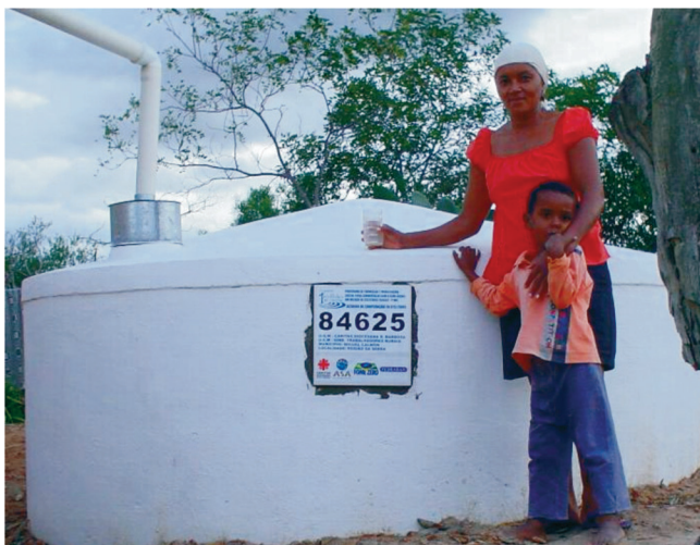
Figura 22. Cisterna de placa de cimento, usada no Programa de Um Milhão de Cisternas (P1MC)
