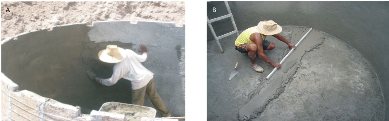
Figura 8. Execução do reboco interno da parede (A) e do fundo da cisterna (B)
