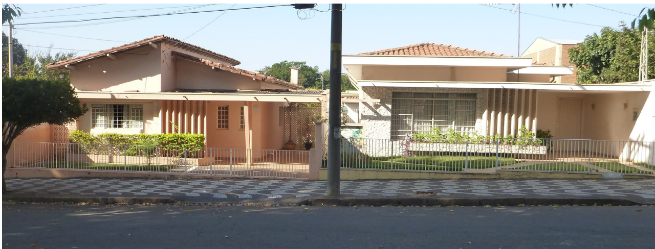
Figura 1. Edificações isoladas - tipologia mais facilmente adaptável à instalação de sistemas de aproveitamento de água de chuva Foto: Luciano Zanella
