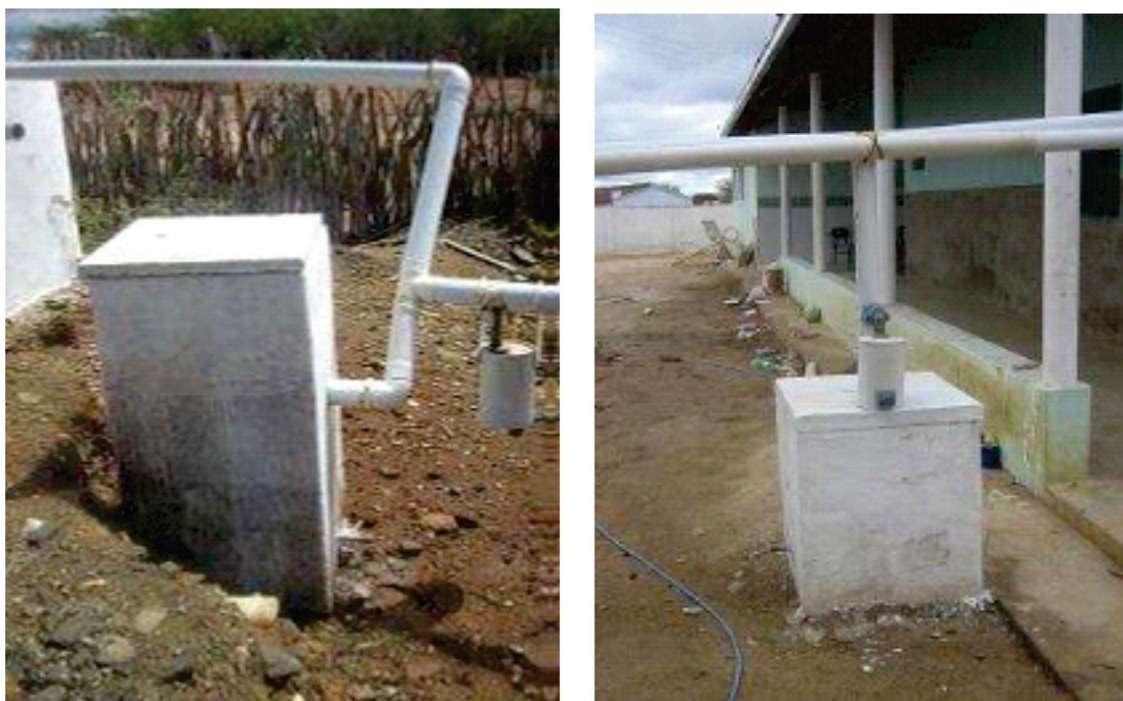
Figura 12. Fotografias dos dispositivos de desvio estudados no Projeto Cisternas Fonte: Xavier et al. (2009)
