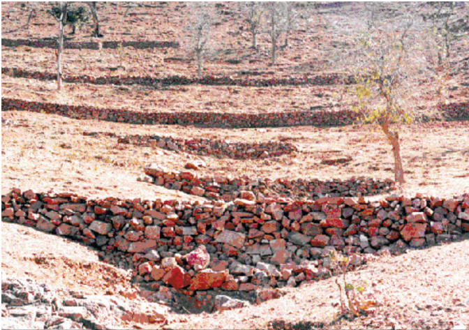
Figura 12. Terraçamentos e barramentos de voçoroca em Gujarat, Índia
