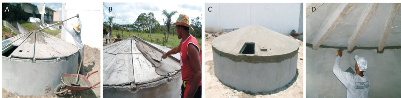
Figura 11. Reboco da cobertura: (A) enchimento da parte central com concreto; (B) e (C) reboco das placas de cobertura; (D) vedação interna
