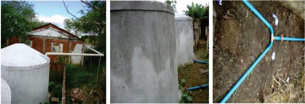
Figura 1. Condução da água de chuva captada para duas cisternas interligadas
