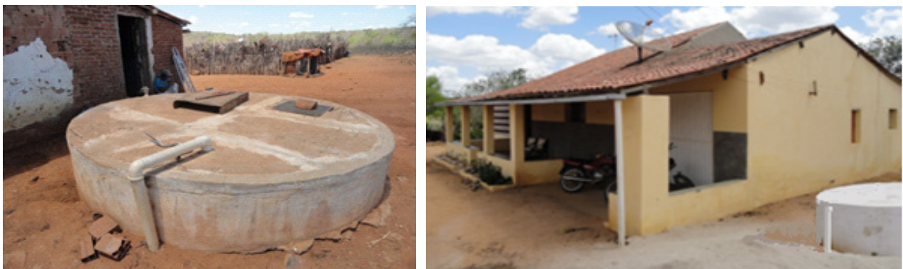
Figuras 8 e 9. Dutos enterrados, expostos apenas nos trechos verticais
