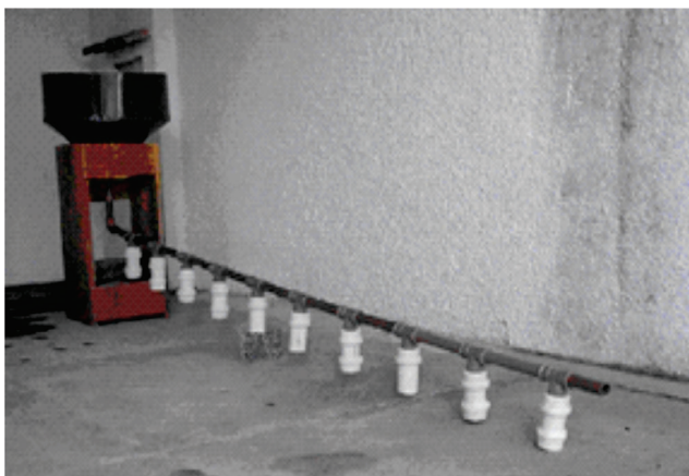
Figura 4. Dispositivo para coletar separadamente os 10 primeiros milímetros da chuva (Melo & Andrade Neto, 2007)
