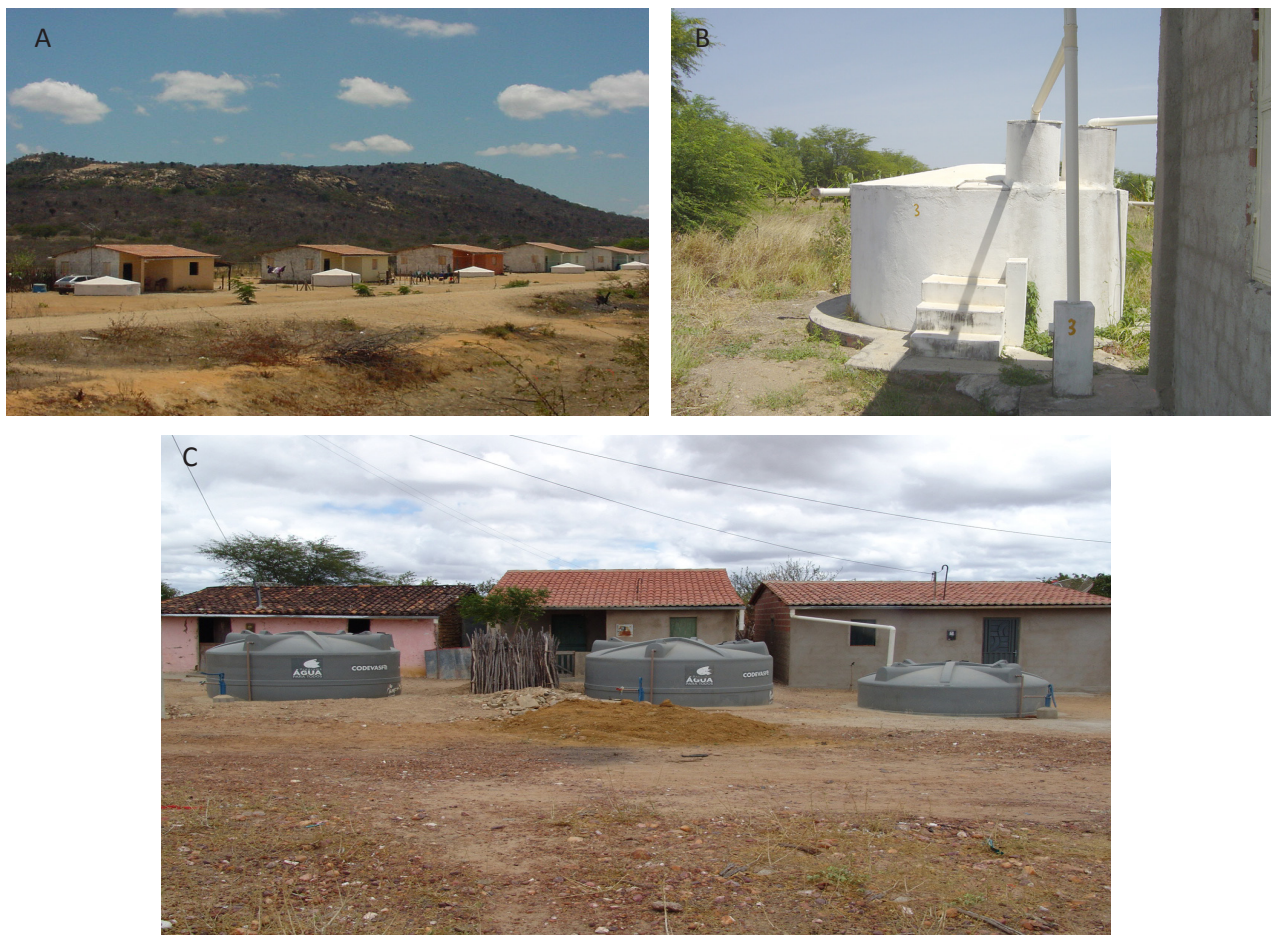
Figura 1. Cisterna de placas pré-moldadas construídas em área de assentamento (A), de tela de alambrado (B) e de Polietileno (C). Fotos: Nilton de Brito Cavalcanti
