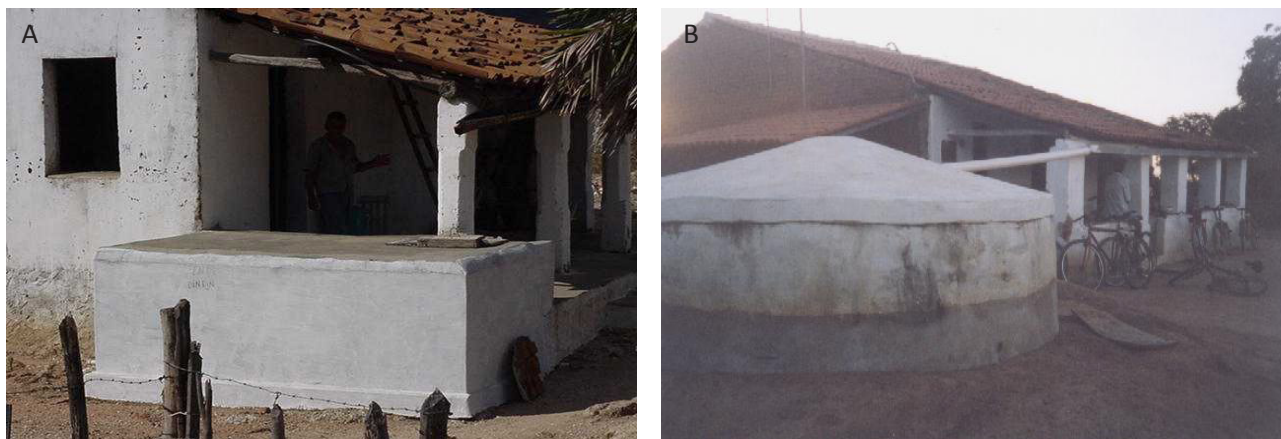
Figura 3. Modelo de cisterna rural antes do P1MC (A); Modelo de cisterna rural do P1MC (B)
