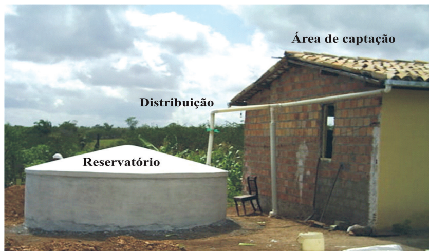
Figura 1. Sistema de aproveitamento de água utilizado no semiárido brasileiro
