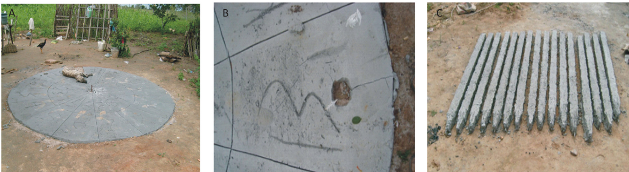
Figura 9. Moldagem das placas de cobertura e caibros
