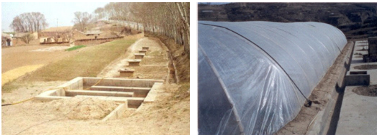
Figura 7. Estruturas de superfície existentes usadas como captação: uma rodovia pavimentada e o telhado de uma estufa
