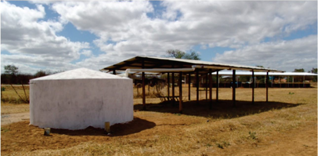
Figura 1. Cisterna e área de captação
