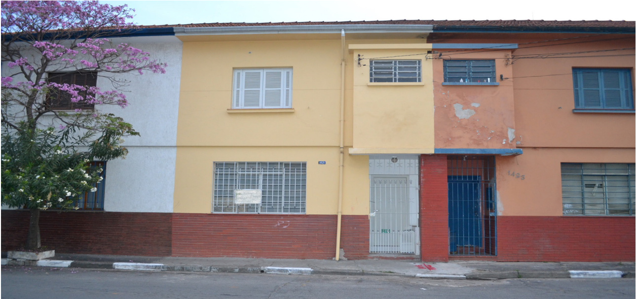
Figura 2. Edificações geminadas – ausência de área para instalação de reservatórios para águas de chuva Foto: Thiago Salaberga Barreiros
