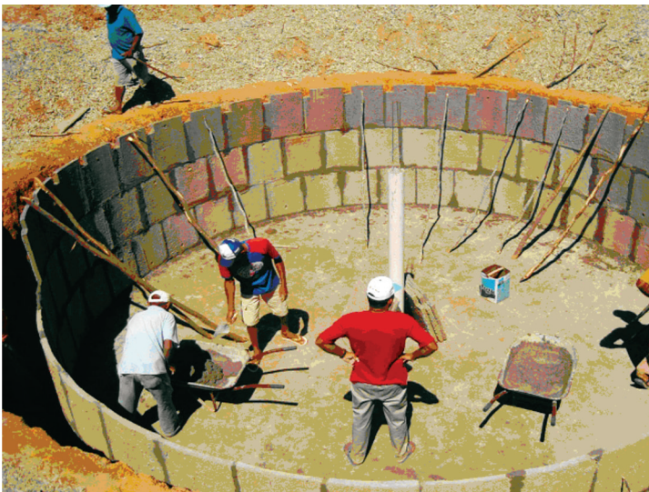
Figura 25. Construção de cisterna para a produção de verduras e fruteiras Foto: Gnadlinger
