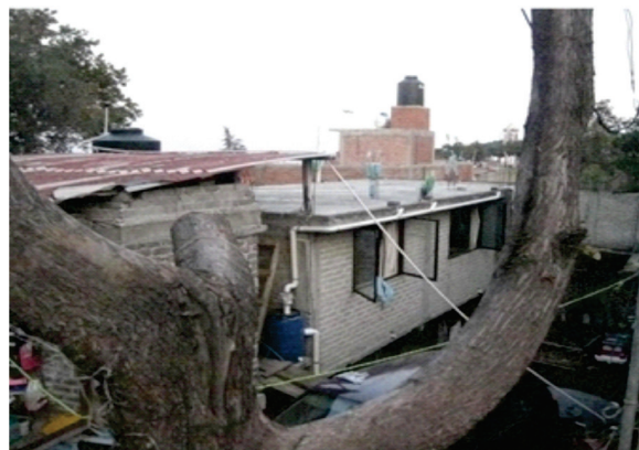
Figura 5. Sistema de captação de água de chuva na Cidade do México.
