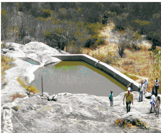
Figura 30. Tanque de pedra
