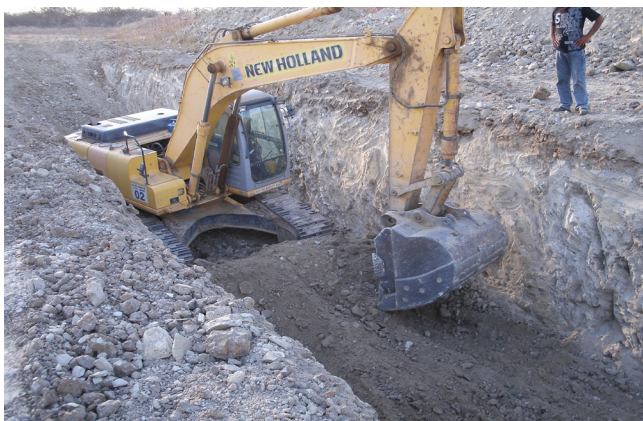
Figura 29. Barreiro trincheira (a máquina escavadeira hidráulica retira a segunda camada, até chegar à profundidade de quatro metros)
