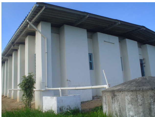
Figura 9. Fotos do dispositivo de desvio automático de desvio do primeiro milímetro, LARHISA da UFRN, em Natal Fonte: Fotos do autor
