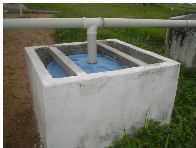
Figura 9. Fotos do dispositivo de desvio automático de desvio do primeiro milímetro, LARHISA da UFRN, em Natal Fonte: Fotos do autor
