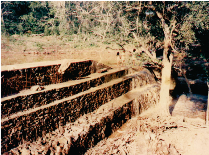
Figura 32 Barragem de gabião Foto: Lima
