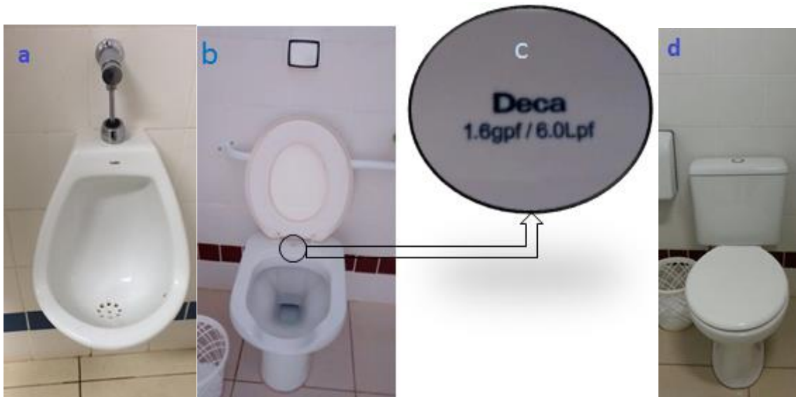
Figura 9 – 9a) Mictório; 9b) Vaso sanitário Convencional; 9c) Informação do fabricante; 9d) Vaso sanitário com caixa acoplada
