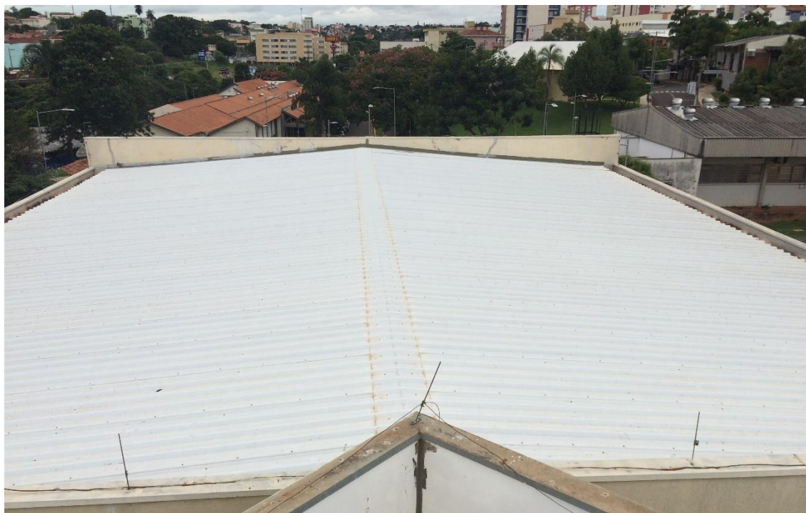
Figura 4. Telhado do setor leste.
