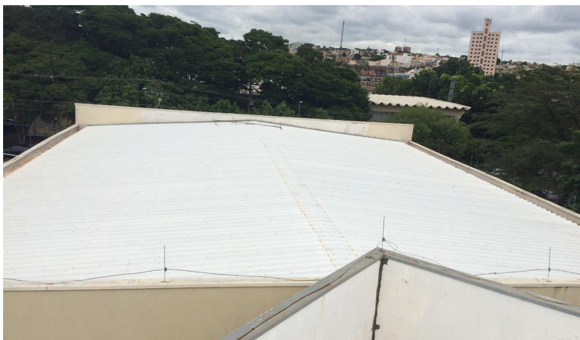
Figura 5. Telhado do setor oeste.
