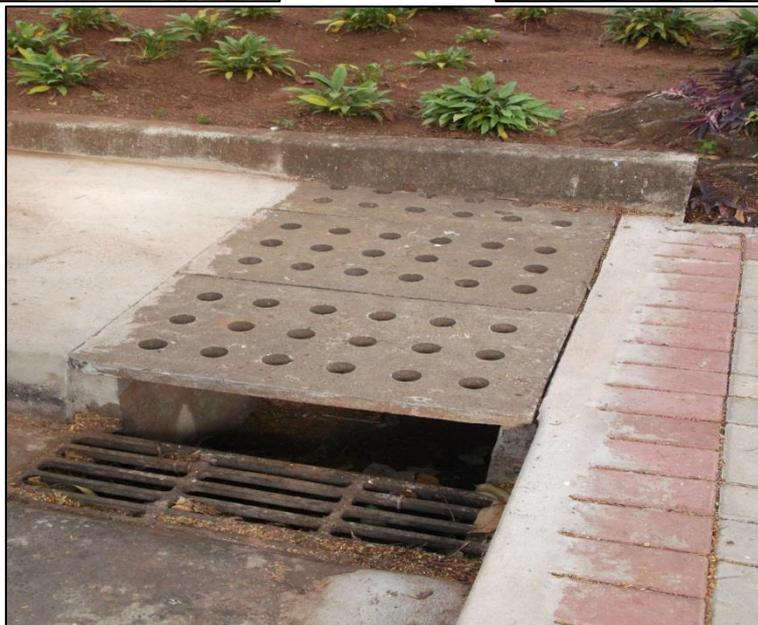
**Figura 9 - Sistema de drenagem de águas pluviais**
