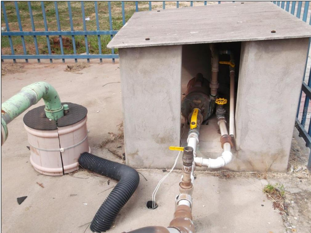
**Figura 4 – Poço de captação de água**
