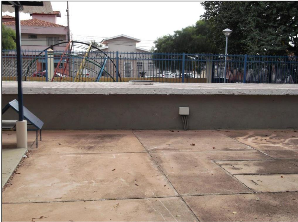
**Figura 6 – Reservatório semienterrado**
