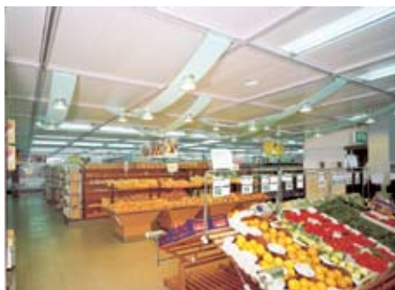
Figura 7 - Exemplo de iluminação geral - Supermercado
