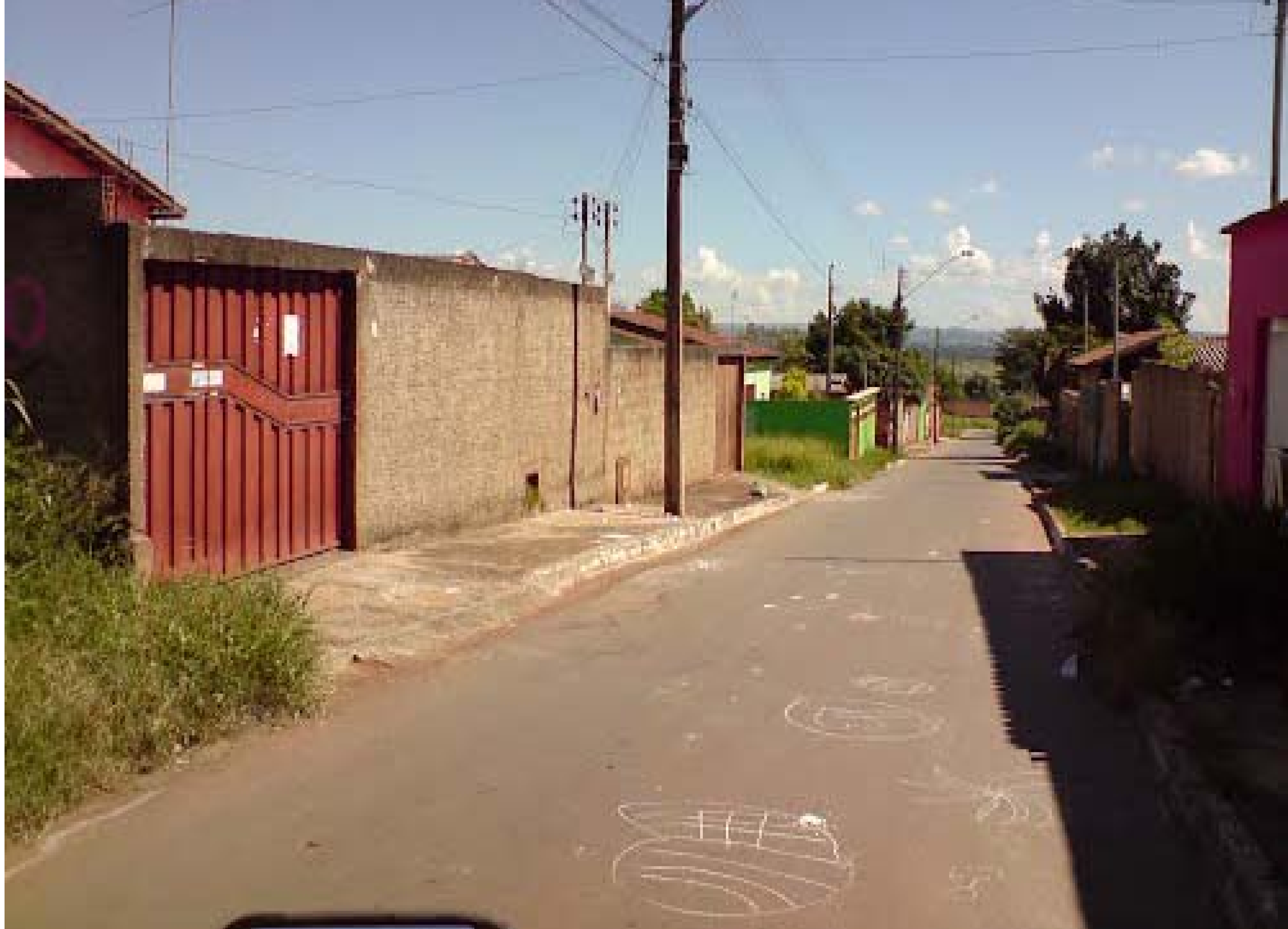
Rua com muros e calçadas sem tratamento contínuo e sem arborização – Rua 7, em Goiânia
