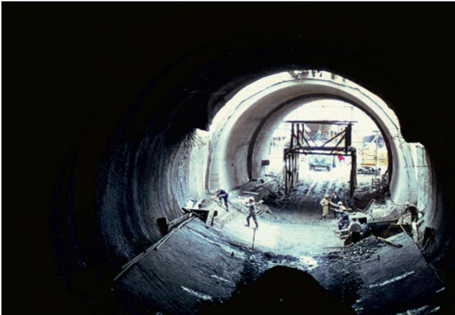
Abb. 8. Neuer Querschnitt mit geschlossenem Sohlgewölbe, im Hintergrund die in offener Bauweise aufgewältigte Verbruchstrecke. Quelle: Archiv der Fa. G. Hinteregger & Söhne Baugesellschaft m.b.H.
