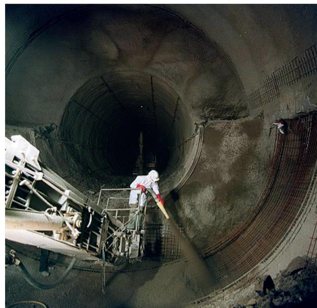
Abb. 3. Stationstunnel, Einbau der Spritzbetonsicherung in der Sohle des Aufweitungsquerschnittes
