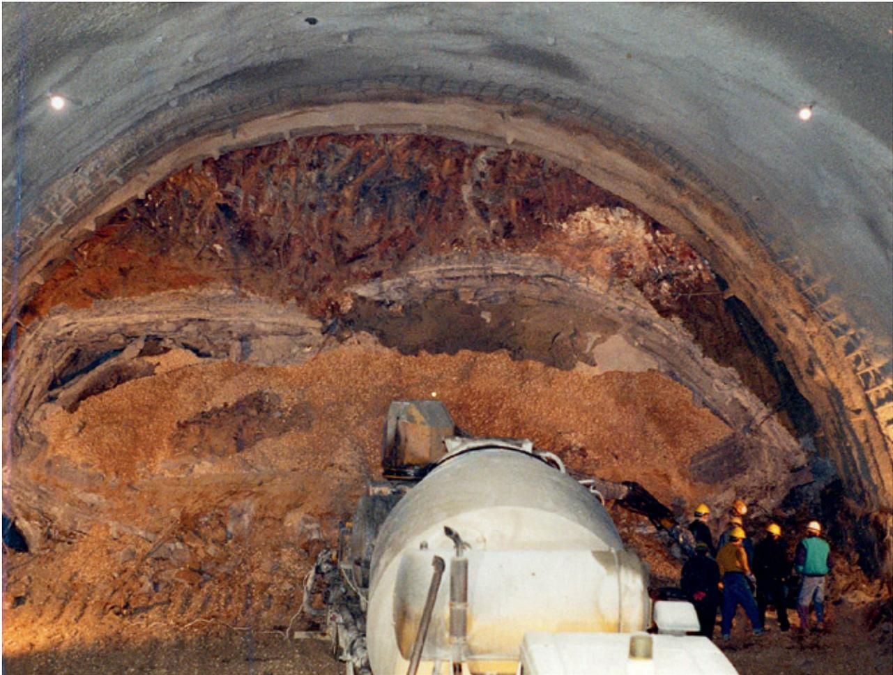
Abb. 2. Verbrauchsbereich Elmalik | Fig. 2. Collapsed Section at Elmalik
