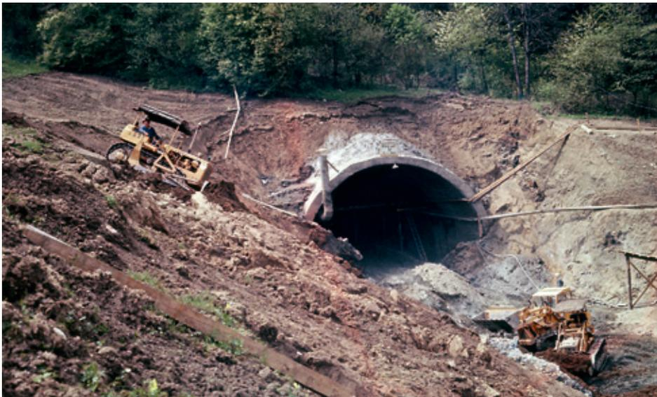
Abb. 5. Herstellung N-Portal, Ausräumen des Verbruchbereiches mit Laderaupen, Neu hergestellter bergmännischer Anschluss nach den Grundsätzen der NATM. Quelle: Archiv der Fa. G. Hinteregger & Söhne Baugesellschaft m.b.H.
