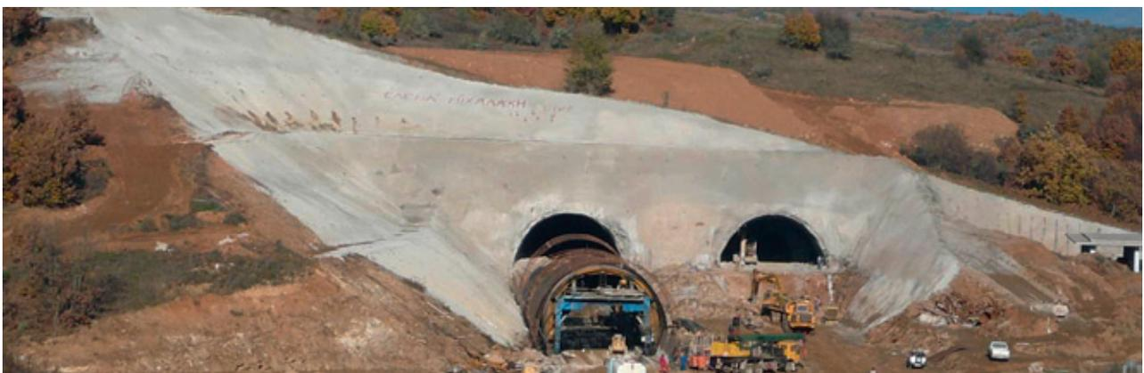
Abb. 2. Ausführung der Wiederherstellungsarbeiten, Verstärkung Außenschale und neuer Portaleinschnitt
