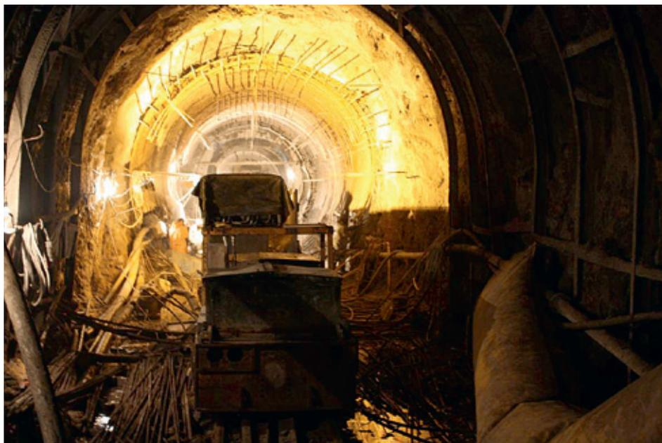
Abb. 2. Risiko Minderung bei starkem Wasser Andrang im Zagros Gebirge, Iran (Einsatz von Hybrid Tunnel Ausbruchsmethoden NATM/TBM)
