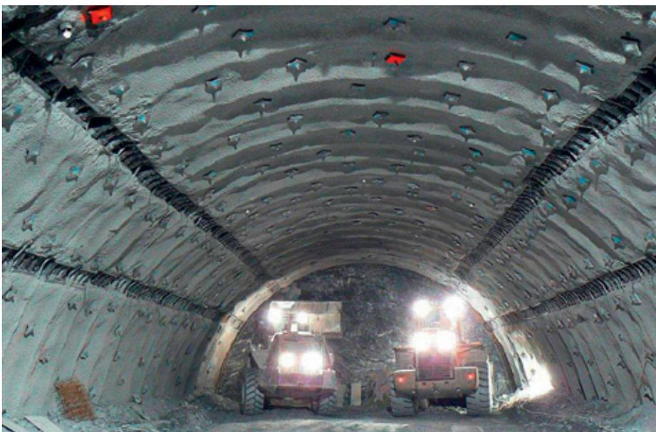
Abb. 4. Verformungsschlitzte | Fig. 4. Deformation slots
