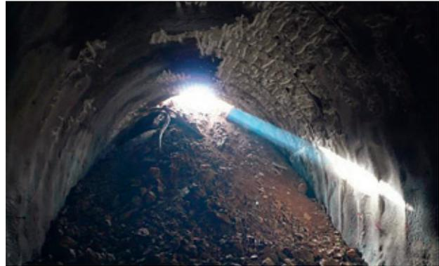
Abb. 1. Dorkada Tunnel, Südportal, Situation unmittelbar nach dem Verbruch
