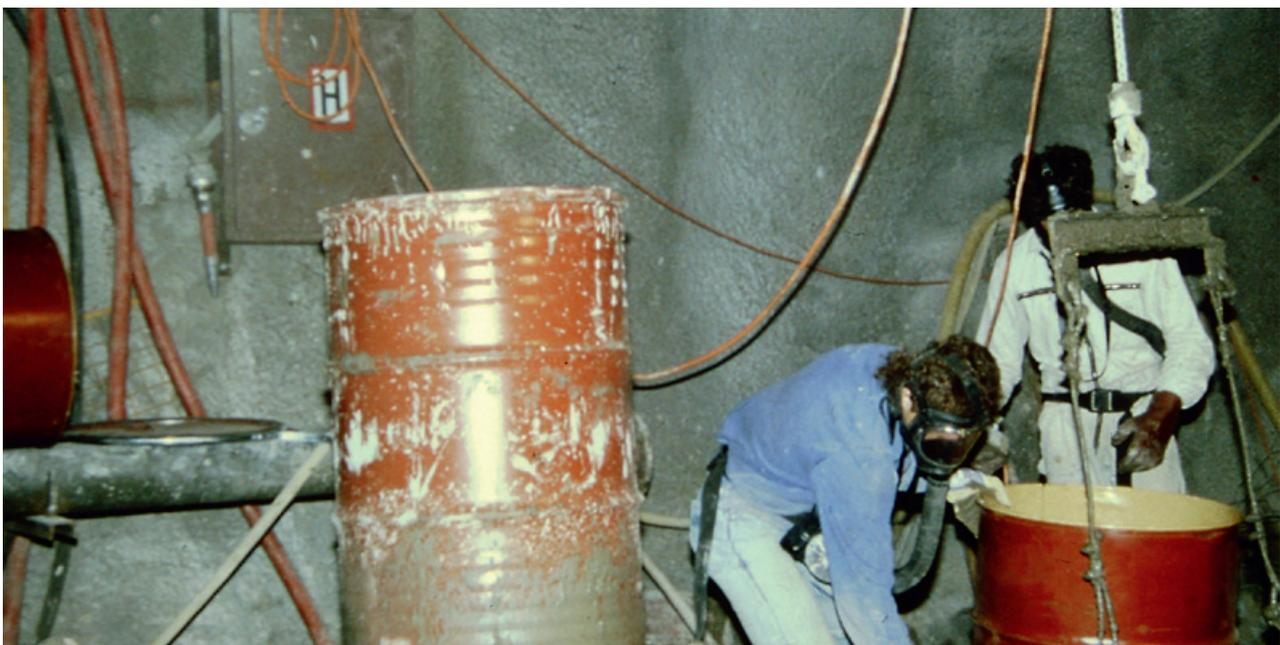
Abb. 3. Verwendung von Atemschutzgeräten bei Antreffen von kontaminierten Böden während der Tunnelbauarbeiten
