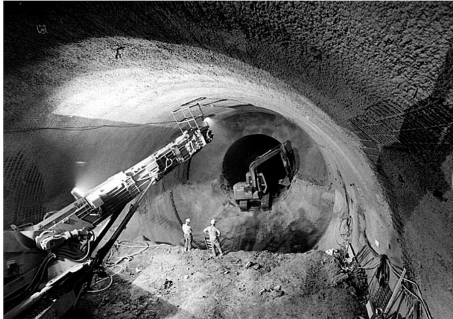
Abb. 5. Verteilertunnel Ost, Sohlausbruch des Aufweitungsquerschnittes vom Pilotstollen aus
