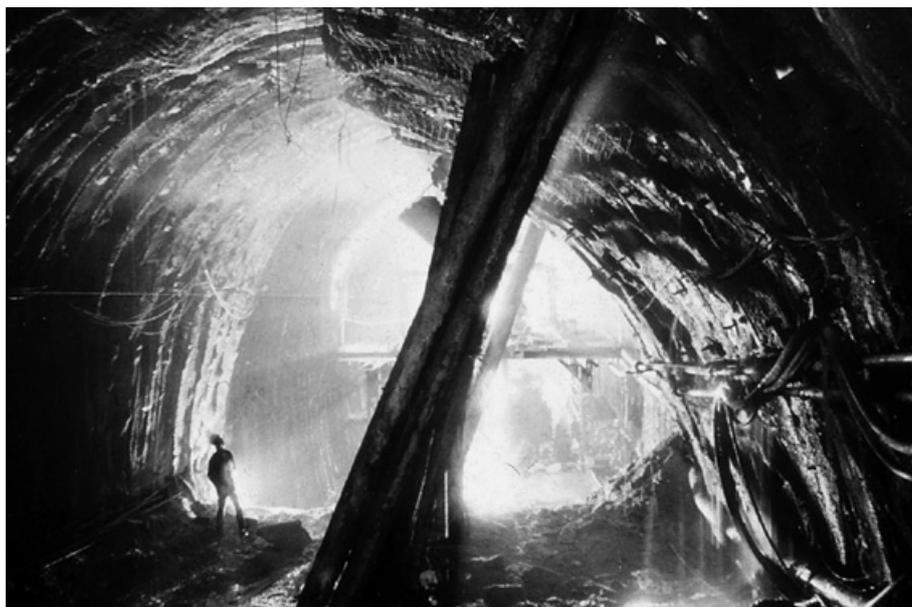
Abb. 1. Tauern Tunnel – Scherbruch | Fig. 1. Tauern Tunnel – Shear failure
