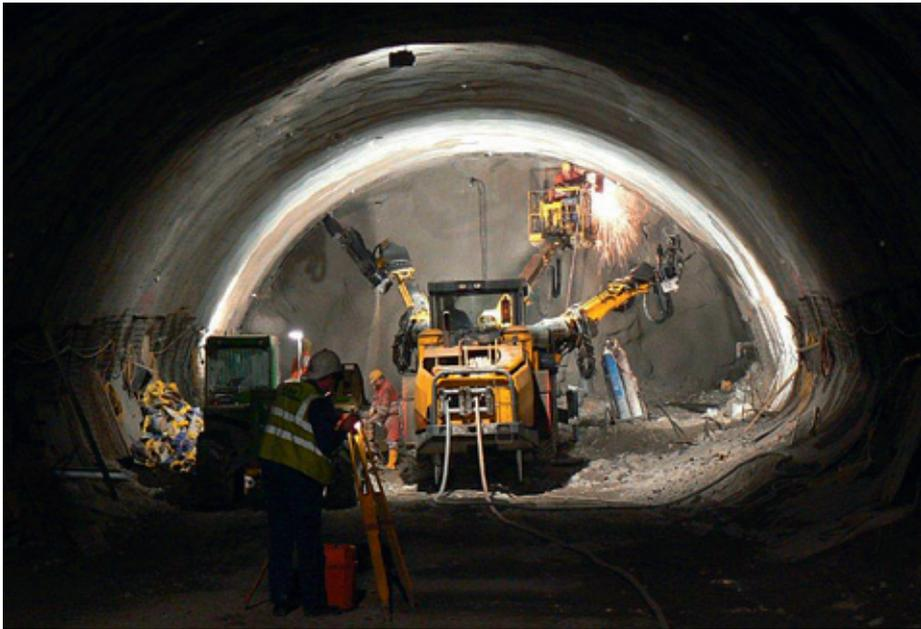
Abb. 3. 2-armiger Bohrwagen | Fig. 3. 2-boom drill jumbo
