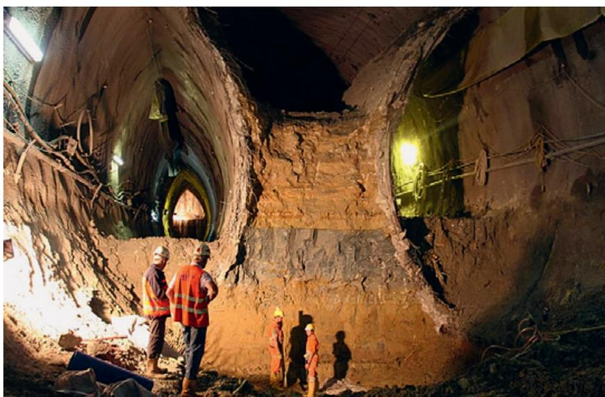
Abb. 5. Lainzer Tunnel – Ulmenstollenvortrieb im Lockergestein unter Bebauung [Foto ÖBA LT31]
