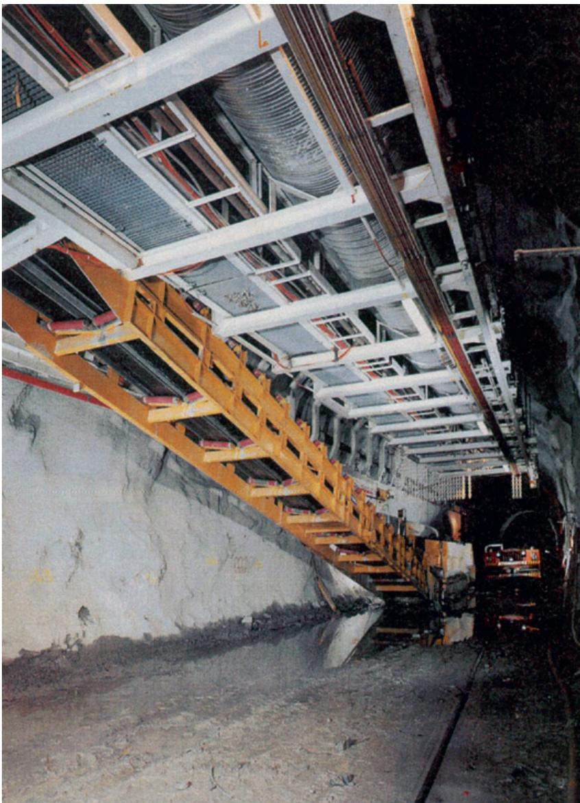
Abb. 4. Hängebühnenkonstruktion Lötschbergtunnel (Foto Rowa)
