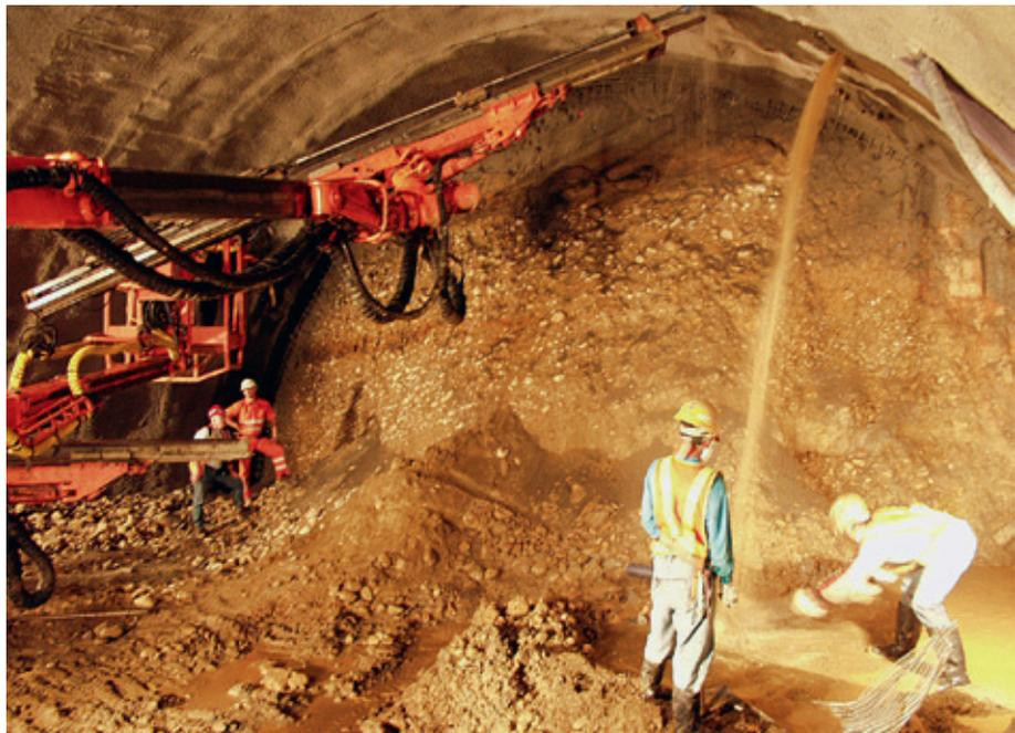
Abb. 3. Wassereinbruch im Paghuashan-Tunnel
