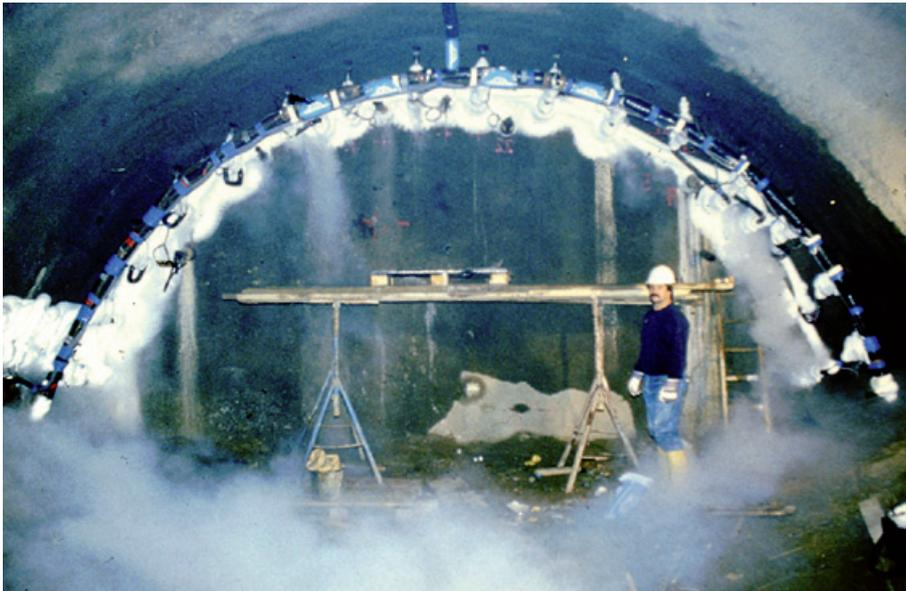
Abb. 2. NATM unter Anwendung des Gefrierverfahrens
