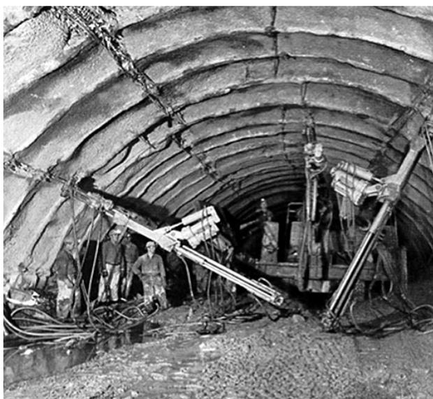
Abb. 3. Tauerntunnel – In Segmente unterteilte Spritzbetonschale mit Verformungsschlitzten [8]
