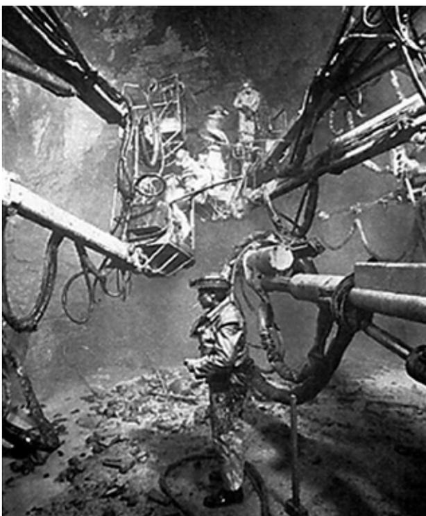
Abb. 4. Bohrjumbos im Einsatz
