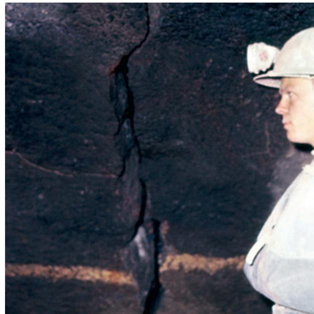
Abb. 3. Deutliche Rissbildung bei Station 15 über den gesamten Querschnitt; Bewegungen führten beim Auffahren der Strosse zum Verbruch von Station 0–27. Quelle: Archiv der Fa. G. Hinteregger & Söhne Baugesellschaft m.b.H.
