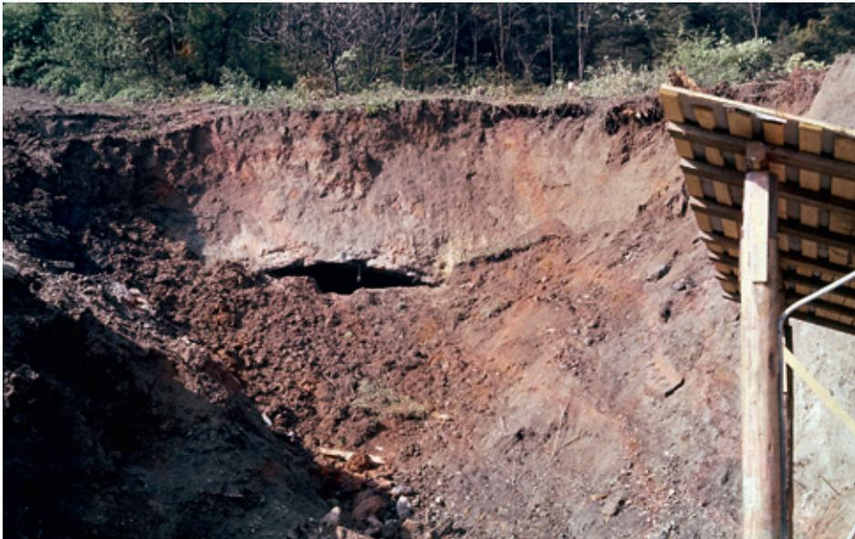
Abb. 4. Tagbruch von Station 0–27, vom restlichen stehen gebliebenen Kalottenbereich ist noch die Kalotte zu sehen. Quelle: Archiv der Fa. G. Hinteregger & Söhne Baugesellschaft m.b.H.
