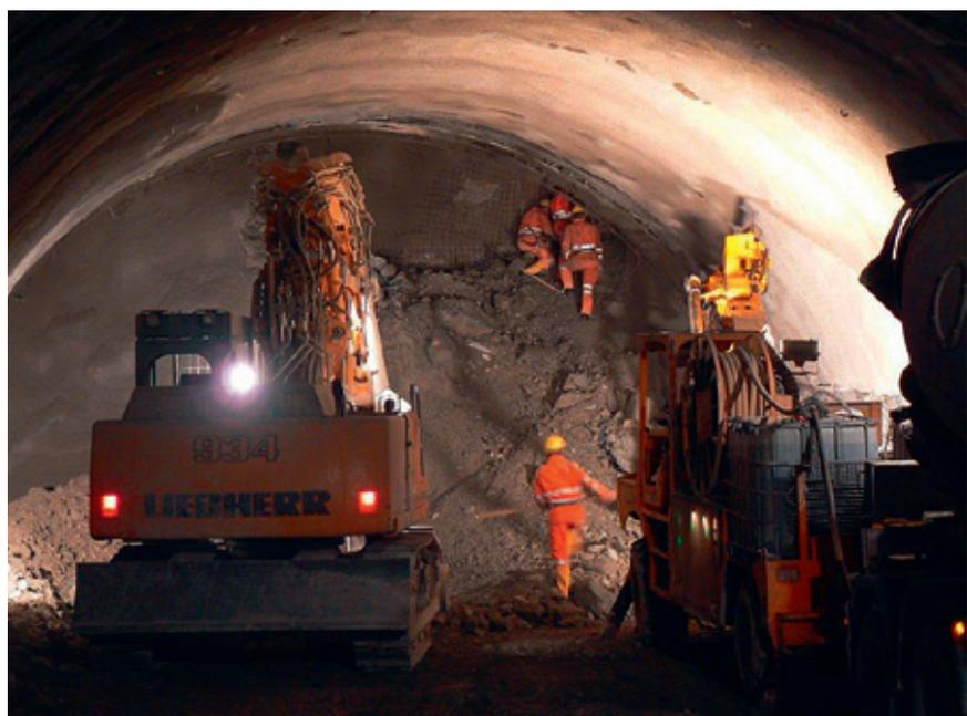
Abb. 2. Vortrieb Hangschuttstrecke | Fig. 2. Tunnelling through talus material
