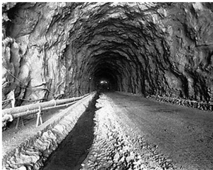
Abb. 2. Fertig ausgebrochener Tunnel vor der Isolierung
