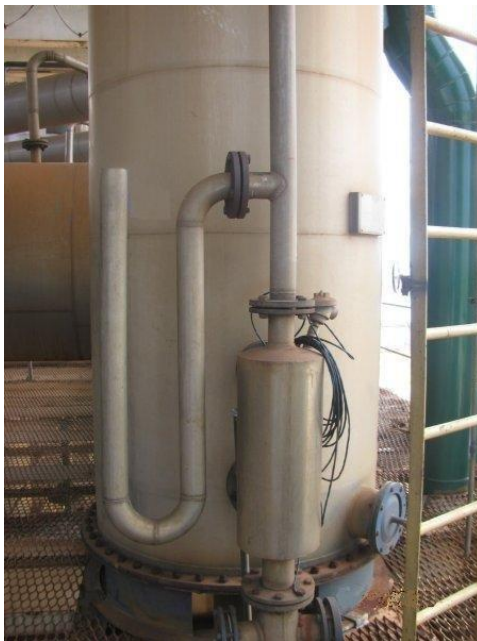
Figura 17 – Proteção contra vácuo utilizando um sifão
