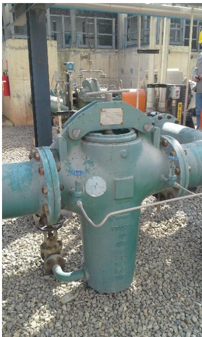
Figura 13 – Filtros que são elementos de tubulação
