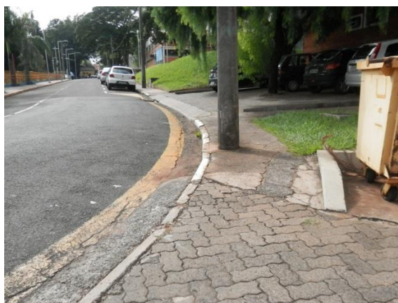
Figura 32: Calçada estreita com poste de iluminação. Fonte: Isabela Pontello. Data: 23/03/2015.
