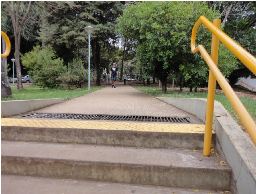
Figura 43 - Acesso a se tornar rampa. Fonte: Juliana Barberio
