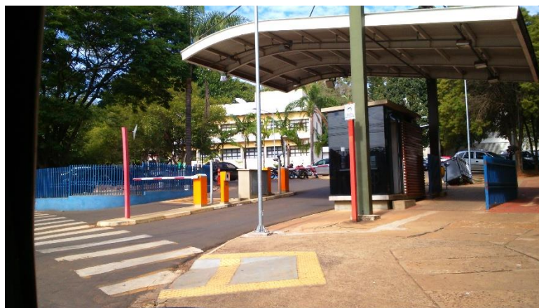
Figura 22 – Entrada na Rua dos Inconfidentes. Entrada confortável para o pedestre, com passagens largas, calçadas com acessibilidade e sinalização. Fonte: Flávia Fonseca. Data: 23/03/2015.
