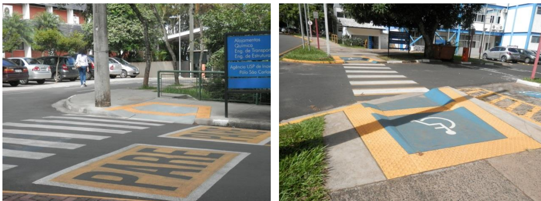
Figura 6 – Rebaixamento da calçada em pontos de travessia, sinalizados pela faixa de pedestres. Fonte: Isabela Pontello. Data: 23/03/2015.
