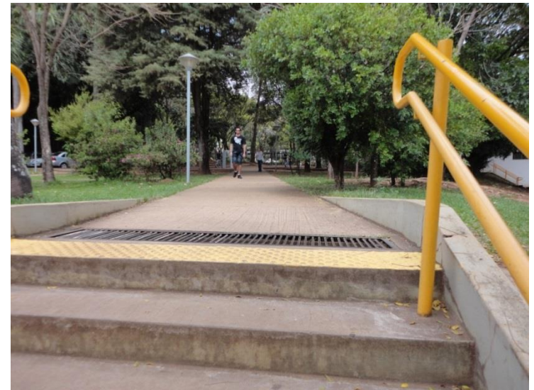
Figura 7: Acesso atual. Fonte: Grupo 4a
