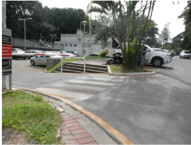
Figura 16 – Não existem calçadas neste trecho, há descontinuidade entre a faixa de pedestres e a escada, além da ausência de rampas. Fonte: Isabela Pontello. Data: 23/03/2015.
