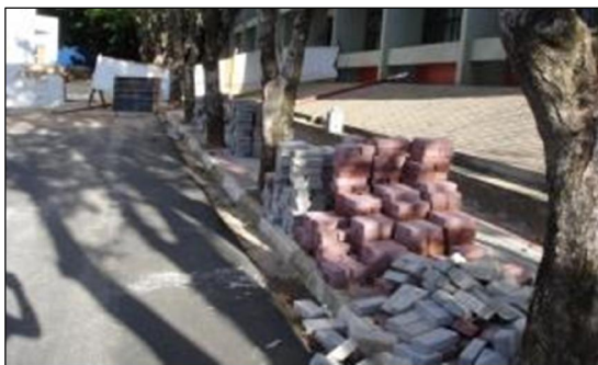
Figura 27: Depósito atrás do Bloco C
