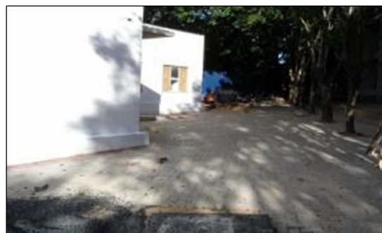
Figura 32: Obra próxima ao ICMC
