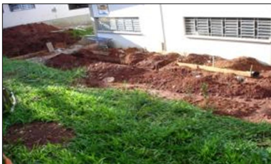
Figura 29: Obra no IQSC
