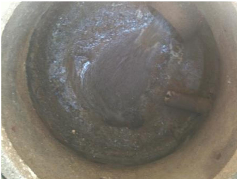
Figura 6. Poço de visita com tubulação não afogada (o Autor, 2012).
