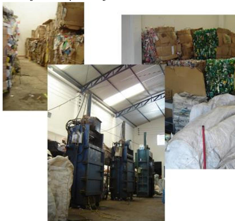
Figura 8: Resíduos compactados e compactadores
