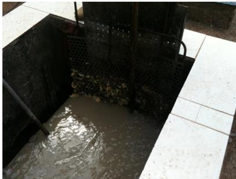
Figura 4. Caixa de separação de vazões da ETE (o Autor, 2012).
