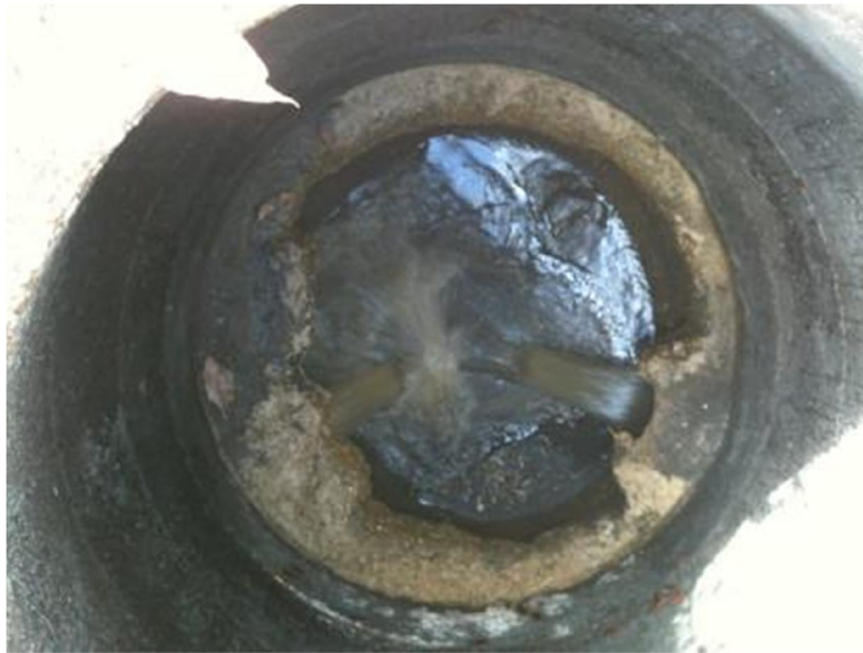
Figura 5. Caixa de entrada da ETE após limpeza.
