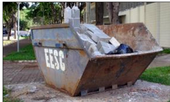
Figura 17: Caçamba no Dpt. Estruturas
