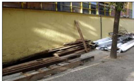
Figura 30: Obra no Restaurante Universitário
