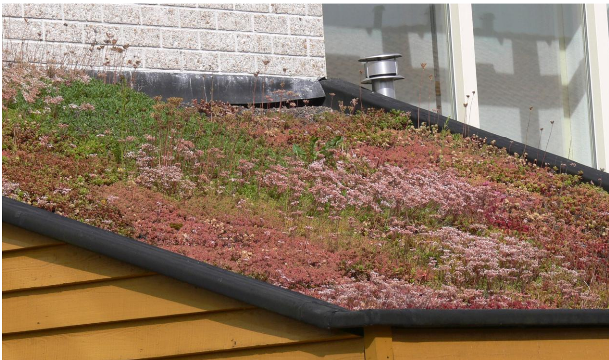
Figura 4 - Telhado verde com captação de água de chuva em EVA-Lanxmeer, Culemborg. Fonte: Lamiot (2009)
