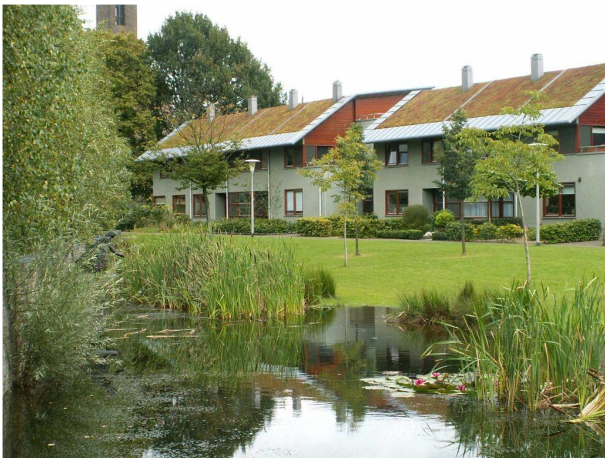
Figura 5 - Bacia de biorretenção e telhados verdes com sistema de captação da água de chuva da cidade de Arnhem, Holanda. Fonte: Buro Lubbers, 2002.
