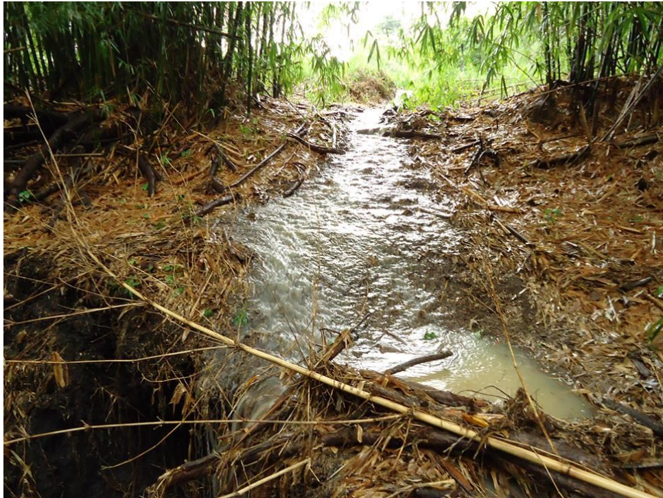
Figura 13 - Escoamento de água pluvial Fonte: (Pedro Zanette, novembro de 2012)
