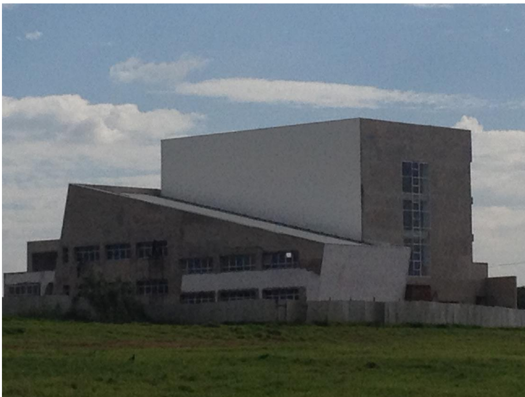
Figura 17 - Prédio de Energias em construção Data: Junho de 2014
