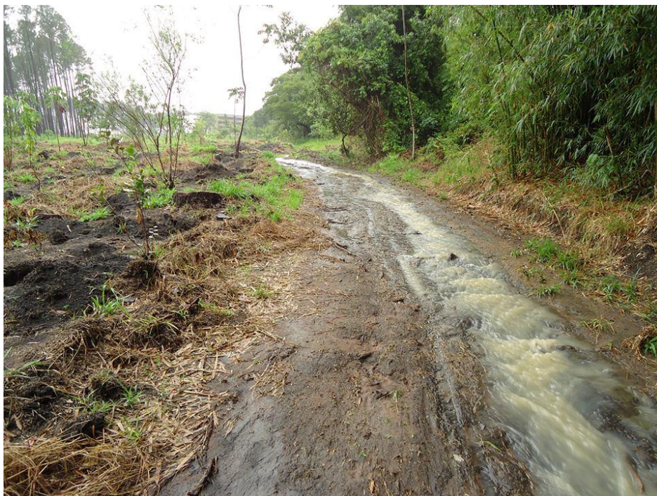
Figura 12 - Escoamento de água pluvial Fonte: (Pedro Zanette, novembro de 2012)
