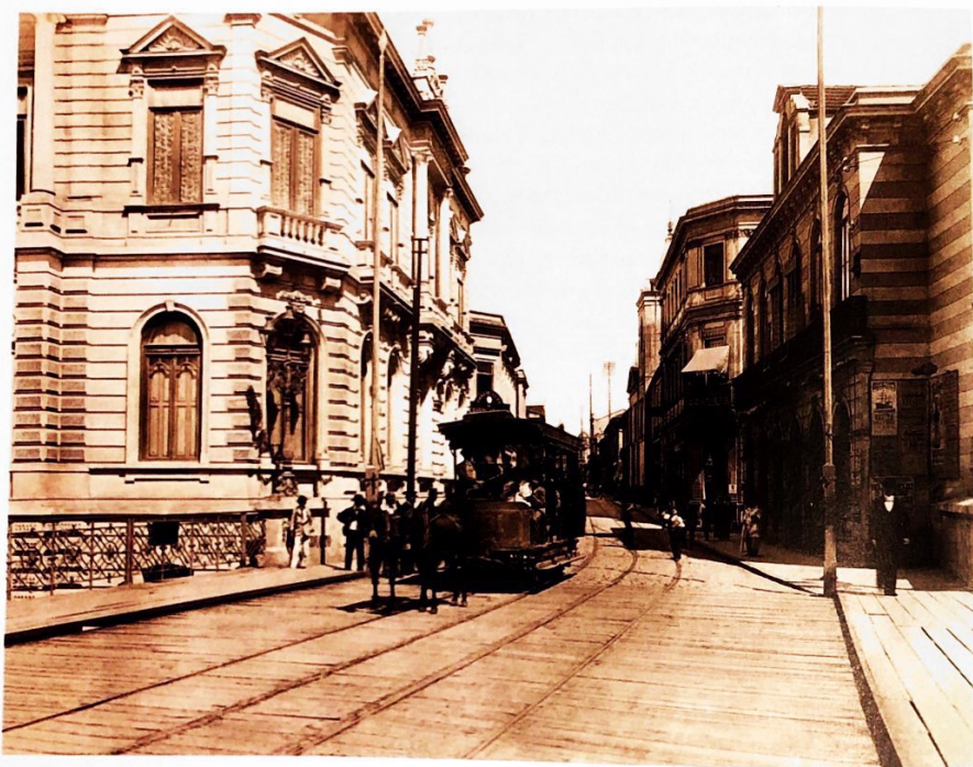
Bonde de tração animal atravessa o Viaduto do Chá, com o piso original de madeira, c. 1895.
