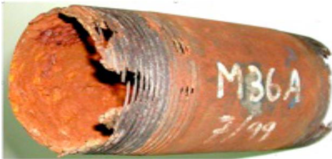
Corrosão no material
