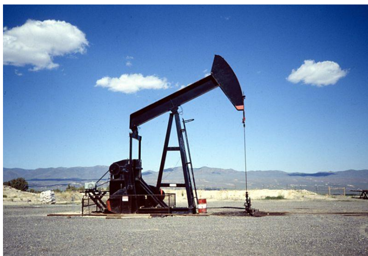
Figura 12 Bombeamento mecânico de petróleo em terra.
