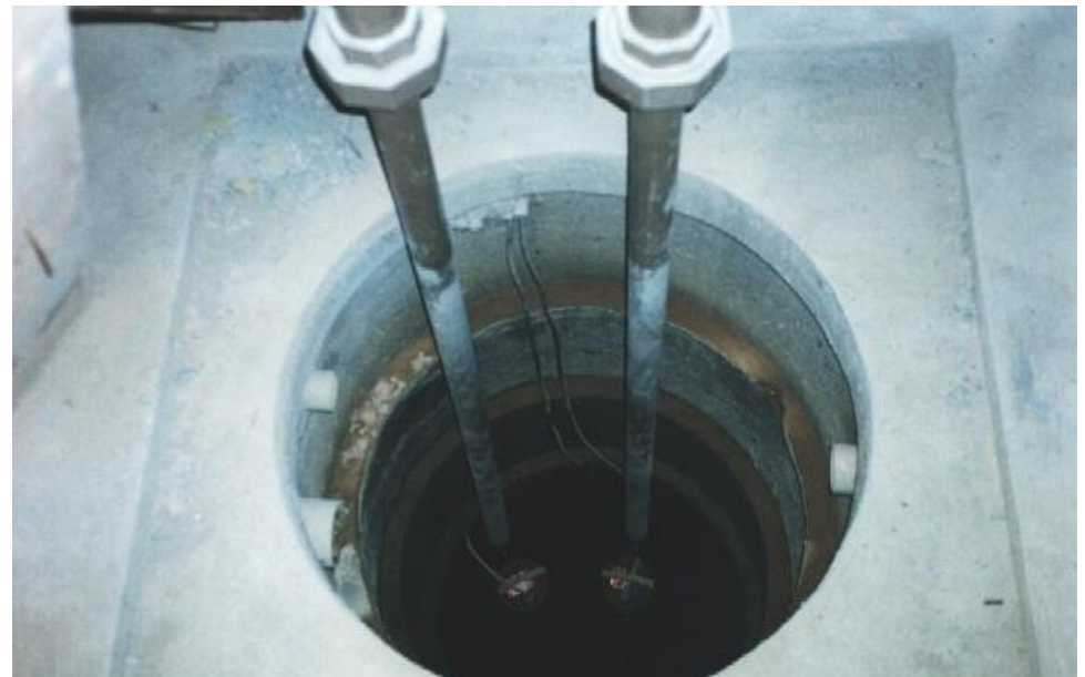
Poço de esgoto sanitário
