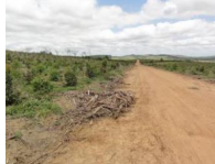
Limpeza das obras de arte
