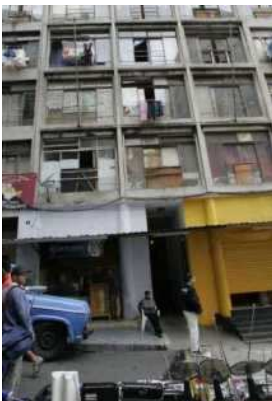
Foto Fachada do Prédio da Rua do Ouvidor: Ocupação MMC
