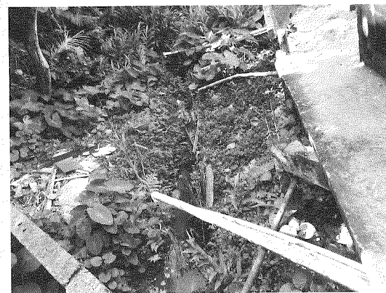
Figura 1 – Lançamento de esgotamento sanitário diretamente no córrego em área de manancial (foto do autor).
