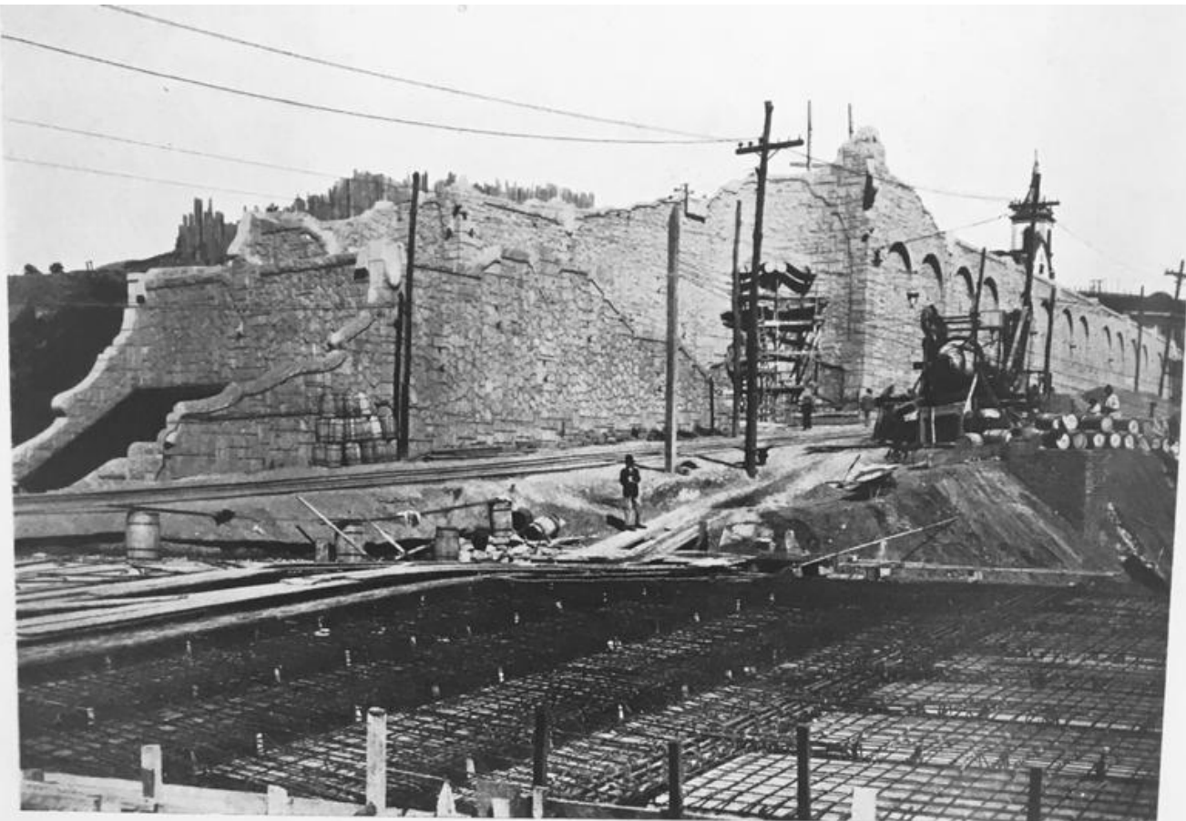
Fig. 202 — Obras da ladeira do Carmo realizadas pela presente administração
