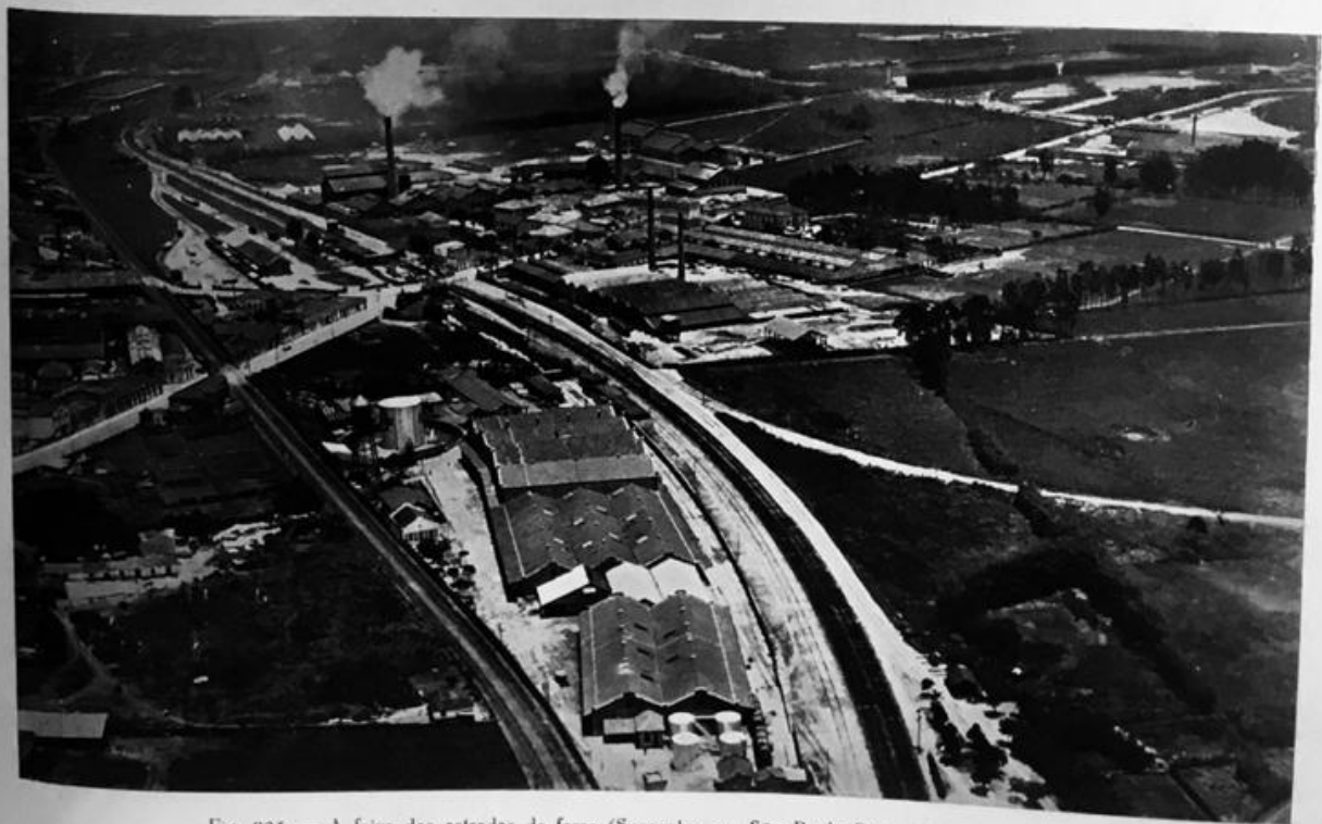
Fig. 205 — A faixa das estradas de ferro (Sorocabana e São Paulo Railway) na Agua Branca
