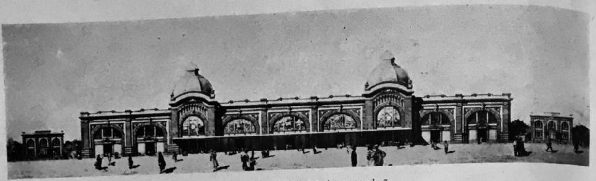
Fig. 84 — Mercado Municipal, em conclusão Proj. Ramos de Azevedo (Construído)
