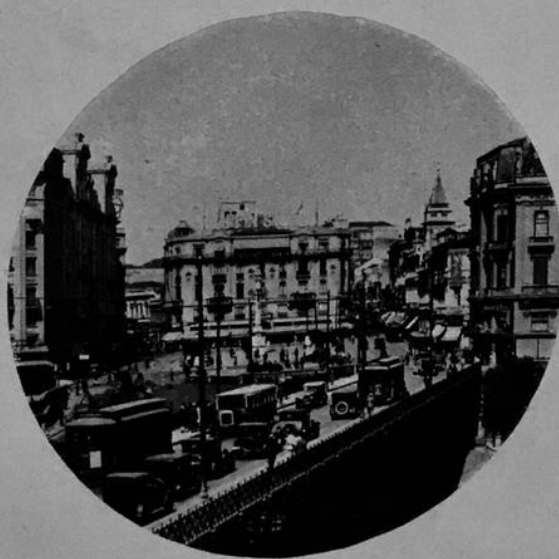
Viaducto do Chá
