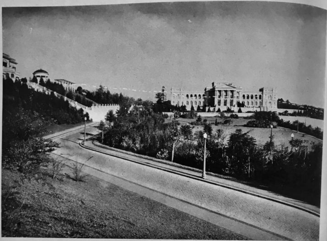
Fig. 94 — Parque da Avenida Independencia O traço indica o nível primitivo do terreno, que occultava o Museu. O córte attingiu 14 ms.
