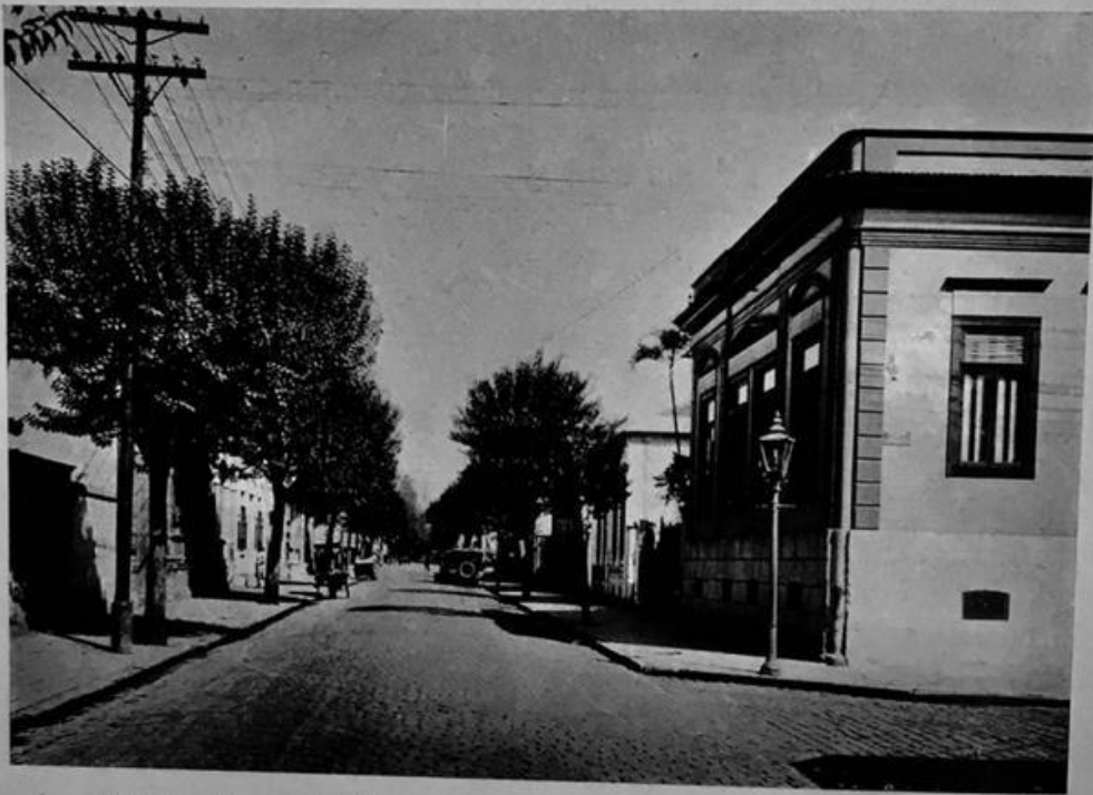
Fig 99 — Praça da Republica vista da Rua Tymbiras. Comparar com plancha fronteira
