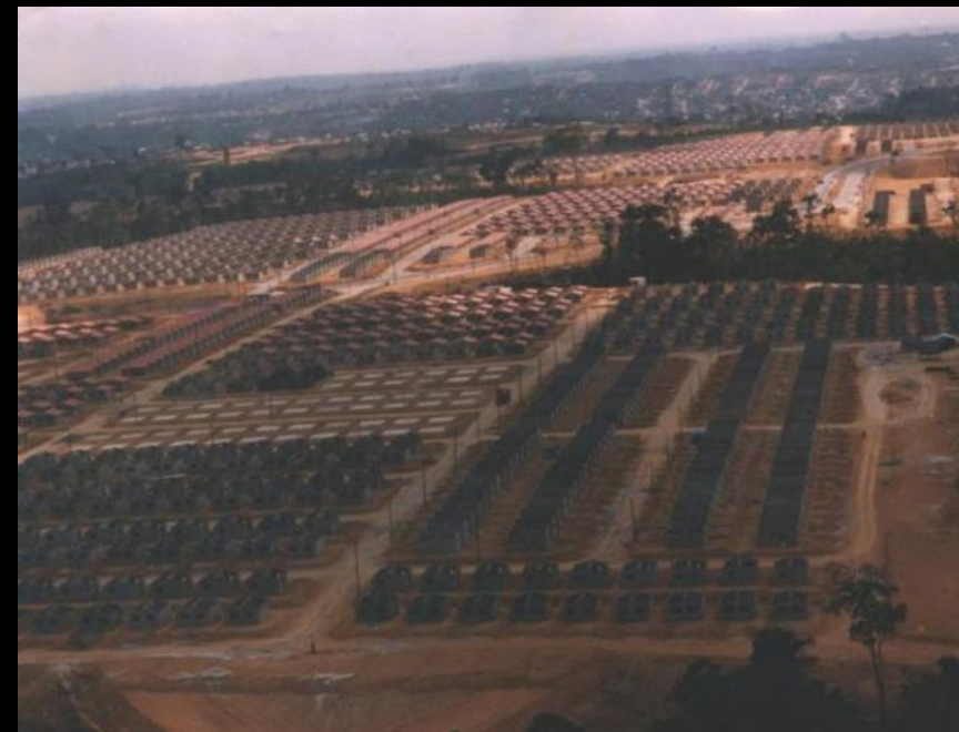
Conjunto habitacional em Manaus– AM, em construção nos anos 1990, Brasil
