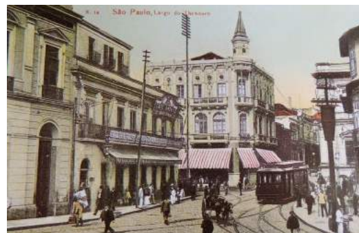
Fig.78 Casa Paiva, no edifício projetado por Samuel das Neves & Carlos Escobar em 1905. GERODETTI et al., 2002, p.41.
