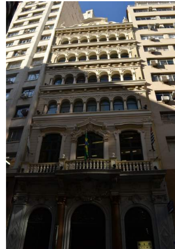
Fig.134 Banco Português do Brasil, 1919, Rua 15 de Novembro n. 194, F. P. Ramos de Azevedo & Cia Engenheiros Architectos. Foto da autora, 2015.
