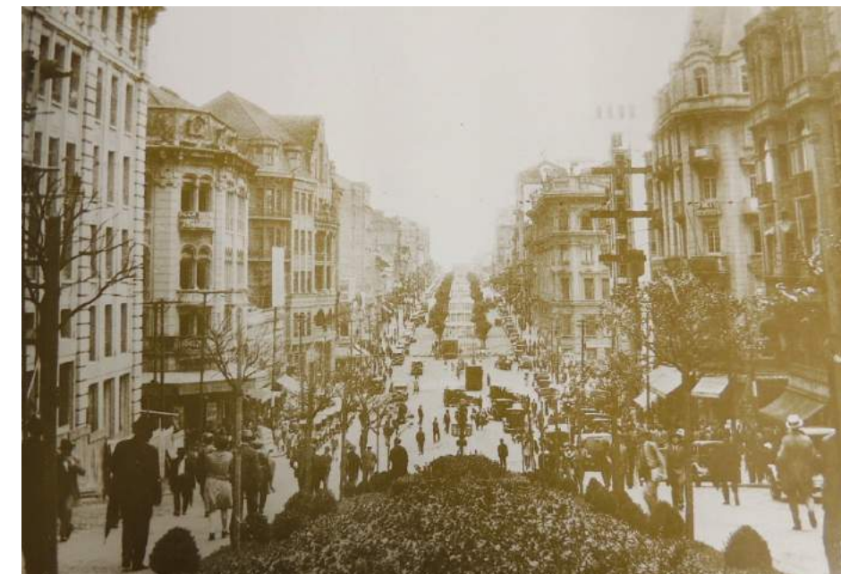
Fig.434 O lado direito da Avenida São João foi quase todo de obras do Escritório de F. P. Ramos de Azevedo & Cia. , realizadas entre 1918 e 1925. Na foto, vê-se a Casa Dhelomme à direita e os Correios ao fundo. SANTOS, 2017, p.232-324.
