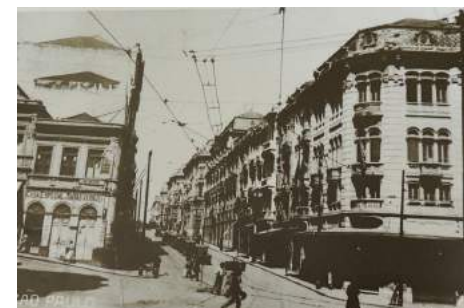
Fig.424 Rua Líbero Badaró, com destaque para a homogeneidade dos edifícios do lado ímpar, e a empena cega do Edifício Stella Penteadado (34m) no lado par (à esquerda). Álbum comparativo da cidade de São Paulo 1862-1887-1914, organizado pelo exmo. Sr. dr. Washington Luís Pereira de Sousa, Prefeito Municipal, Prefeitura Municipal de São Paulo. SIMÕES Jr., 2004, p.145.
