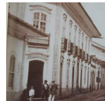
Fig.238 O sobrado de taipa de pilão foi demolido e deu lugar a este construído em 1908. Consta no AHSP, na Série Obras Particulares (OP 1908-001.721-Pr.1-3) o projeto encaminhado à Prefeitura para aprovação, apresentando como interessado João Eusébio Peixoto e o construtor Manoel Asson, abrasileiramento de Emmanuele Asson ou Irmãos Asson. Regina Santos atribui o projeto a Max Hehl.
