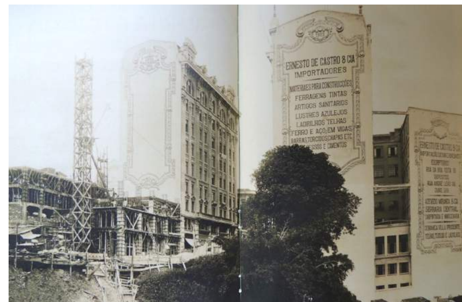
Fig.452 Edifício Condessa Siciliano em obras e à esquerda o Casa Palmares (1922) e à direita o Casa Ramos de Azevedo. GONZALEZ & NOVAES, 2012.
