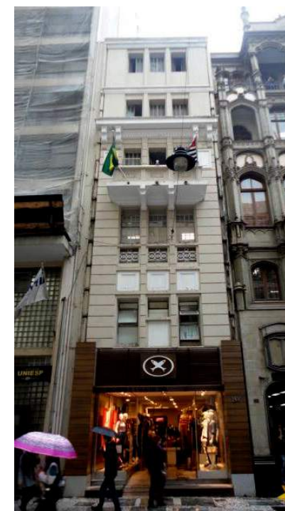
Fig.91 Prédio para Jacob Levy, 1910. Foto da autora, 2015.
