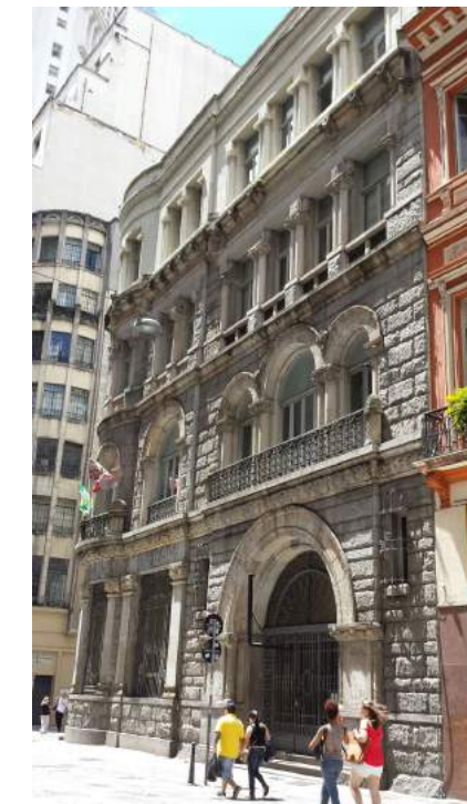
Fig.124 Ao fundo, vê-se o prédio art déco dos Irmãos Netter, com projeto datado de 1932, assinado pelo Escritório Técnico do Engenheiro Antonio Bayma. Foto da autora, 2015.
