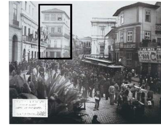
Fig.77 Casa Paiva - sobrado de taipa de pilão de 4 pavimentos, edificado por Domingos Paiva, c. 1852. Acervo da Fundação Patrimônio Histórico da Energia de São Paulo.
