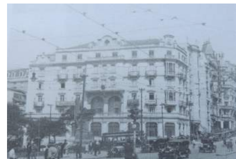
Fig.435 O conjunto de edifícios do lado direito da Avenida São João visto de outro ângulo. No primeiro plano está o neocolonial Edifício Baraúna (1923), projetado por Ricardo Severo no escritório F. P. Ramos de Azevedo & Cia. , ladeado pelos dois prédios para Daniel Dhelomme. (SANTOS, 2017, p.232-324).
