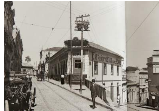
Fig.415 Casa de Empréstimos e Penhores de Luís Medici, antes da demolição. Aurélio Becherini. Casa da Imagem.
