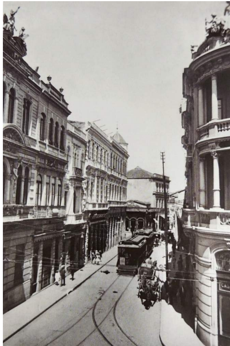
Fig.174 Quadra 1 da rua Direita, c. 1911. À esquerda, vê-se parte do Palacete Baruel , seguido da Confeitaria Fasoli (que alugava o prédio da Sociedade Beneficente Portuguesa) e pelos dois edifícios idênticos alugados para as casas de materiais elétricos James Mitchell e Guinle. À direita, o Palacete Tietê , com a Casa Lebre embaixo (BARBUY, 2006, p.126). Fotografia de Guilherme Gaensly. Acervo da Fundação Patrimônio Histórico da Energia de São Paulo.
