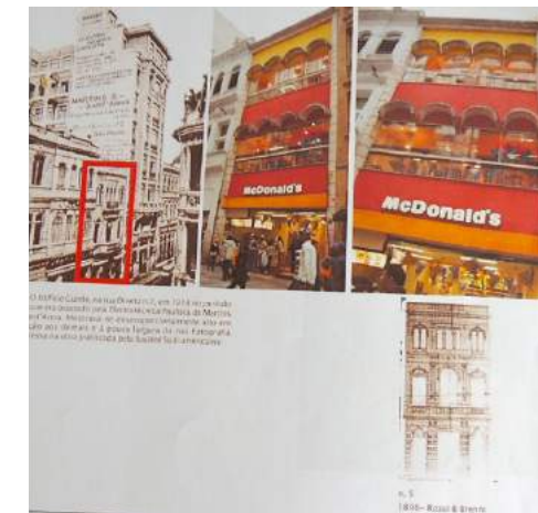
Fig.173 Quadra 1: Exercício comparativo realizado pelo aluno Gustavo Vanini para a disciplina AUH 238, em 2014. Foto publicada em A Cidade da Light, 1899-1930, v.1. Na imagem vê-se o predinho demolido para dar origem ao Guinle. Acervo da Fundação Patrimônio Histórico da Energia de São Paulo.
