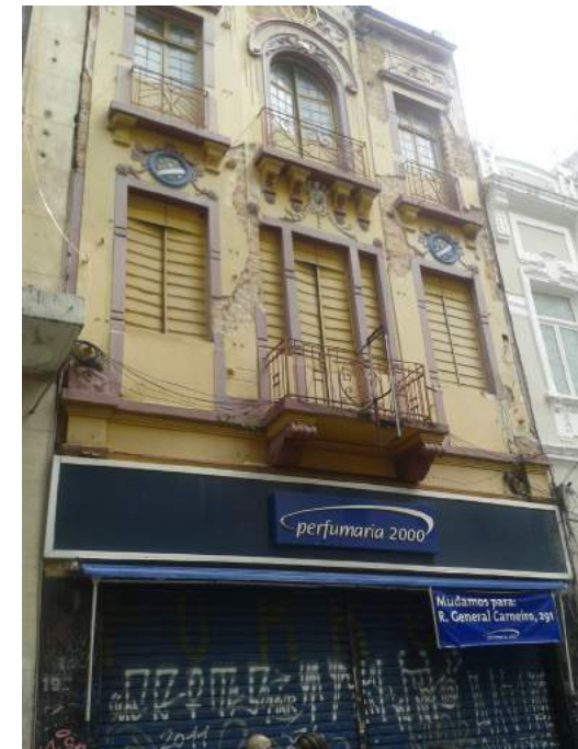
Fig.195 Projetado para Luiz Henrique Levy em 1907 e reformado em 1919 pelo construtor Antônio Stefani para Armando Álvares. Foto da autora, 2015.
