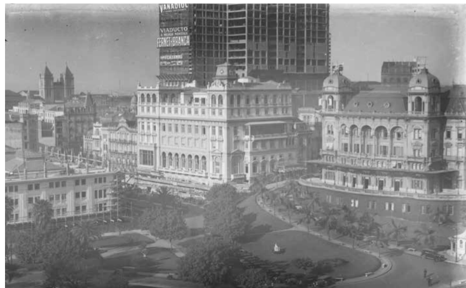
Fig.343 Clube Comercial à esquerda, obra do escritório de Ramos de Azevedo, 1929. No fundo, o Edifício Martinelli (72,5m) destaca-se ainda em construção, rompendo o skyline. FAUUSP.
