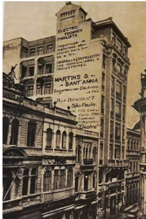
Fig.175 A Cidade da Light , 1899-1930, v. 1. Na imagem vê-se o predinho demolido para dar origem ao Guinle. Acervo da Fundação Patrimônio Histórico da Energia de São Paulo.
