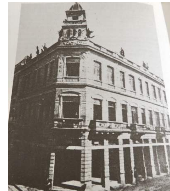
Fig.202 Edifício projetado por Francesco Notaroberto entre 1907 e 1908, com laje de concreto armado. Le Messenger de Saint Paul . São Paulo, 1907 apud REIS, 1994, p.150.
