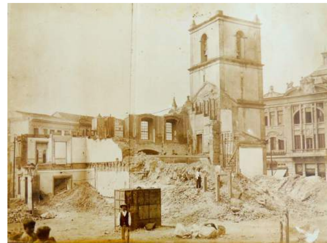
Fig.442 Demolição da Igreja da Sé em 1912. Afonso de Freitas (LEMOS, 2001, p.26-35).
