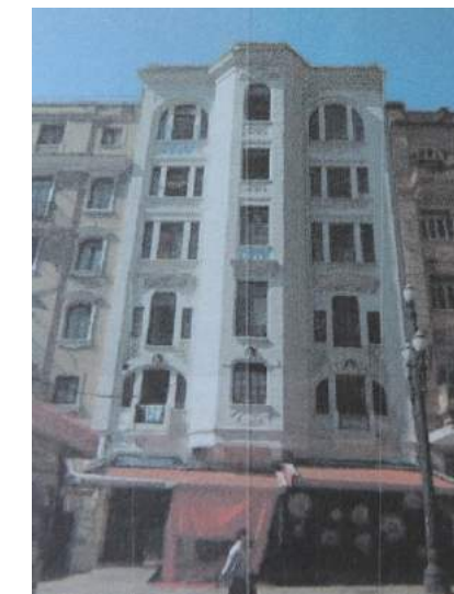
Fig.440 Prédio para Daniel Dhelomme (1922), entre o Edifício Baraúna (1923) e o Casa Dhelomme , (1922-1925), todos projetados pelo Escritório F. P. Ramos de Azevedo & Cia. quase simultaneamente. Dada a pequena dimensão e a exiguidade do terreno, observar a solução do bow-window saliente menos de 12,20m, tal como prescrito no Padrão de 1920 . SANTOS, 2017, p.232-324.
