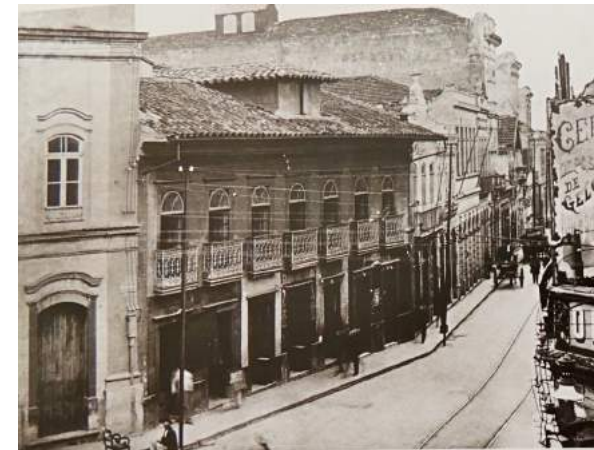
Fig.404 Rua do Rosário esquina com atual João Bricola. Vê-se à esquerda parte da antiga Igreja de N. S. do Rosário dos Homens Pretos, assim como o sobrado desapropriado para dar lugar à Praça Antônio Prado segundo a Lei n.º 917 de 6 de julho de 1906 . Foto de Afonso de Freitas. Álbum comparativo da cidade de São Paulo 1862-1887-1914, organizado pelo exmo. Sr. dr. Washington Luís Pereira de Sousa, prefeito municipal, Prefeitura Municipal de São Paulo. SIMÕES Jr., 2004, p.151. Também em LEMOS, 2001.
