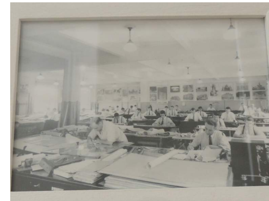
Fig.362 Interior da Seção de Desenho do escritório no Edifício Britânia sito à rua Libero Badaró, 13º andar. Coleção dos Herdeiros de Arnaldo Dumont Villares.
