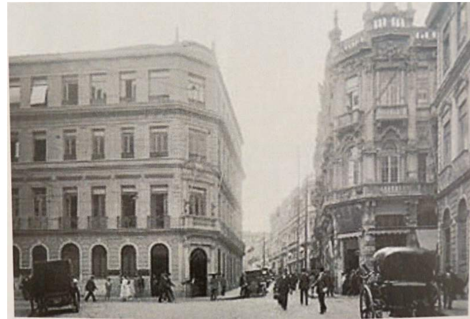
Fig.184 À esquerda vê-se o prédio das Indústrias Reunidas Matarazzo construído em 1915 e, à direita, o Palacete Tereza de Toledo Lara edificado em 1908. Ambos passaram a compôr o Largo da Misericórdia remodelado em 1903.
