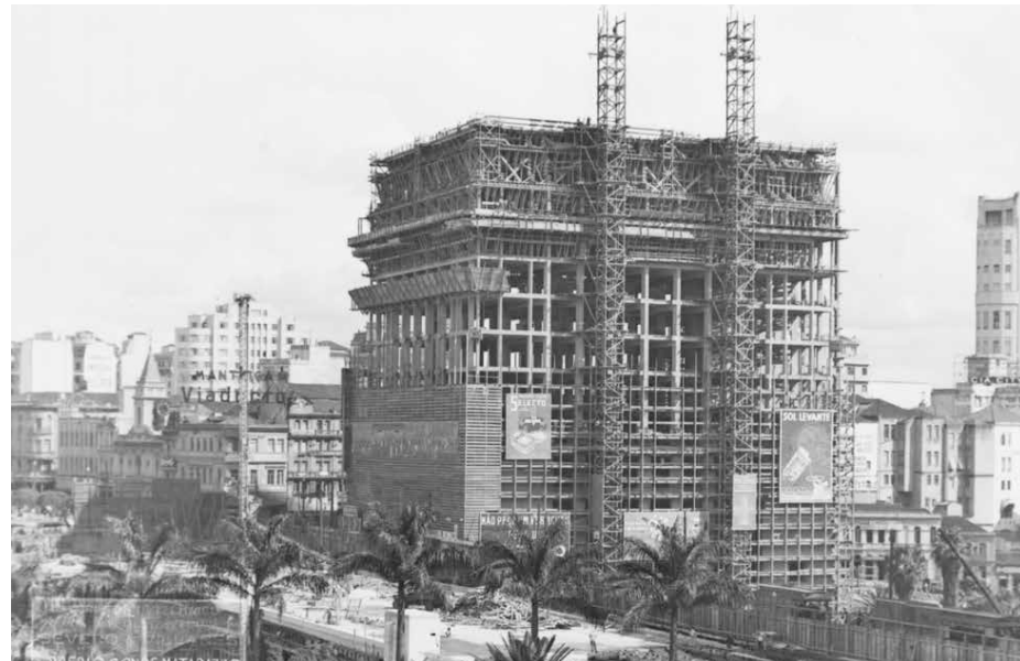
Fig.458 Edifício Conde Matarazzo em obras, 1937. Acervo FAUUSP.
