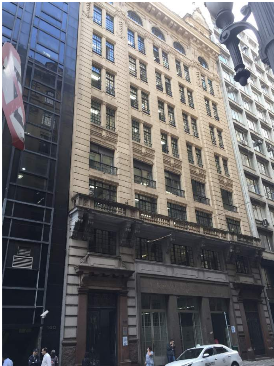
Fig.349 Casa Ramos de Azevedo, projetado por F. P. Ramos de Azevedo & Cia. em 1922, propriedade do arquiteto, destinado a sediar seu escritório e a Cia. Iniciadora Predial , bem como a Casa Ernesto de Castro no térreo. Foto da autora, 2017.
