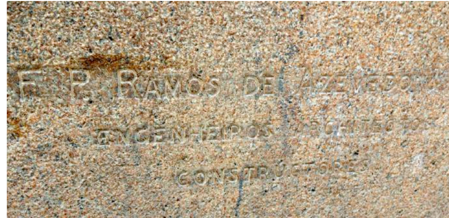
Fig.352 Epígrafe estampada na fachada do Edifício Lutétia do Escritório F. P. Ramos de Azevedo & Cia , responsável pelo projeto.
