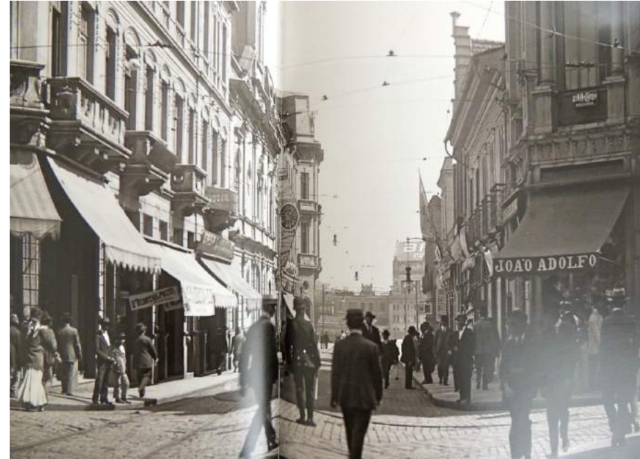
Fig.207 Rua Direita esquina com Libero Badaró. À esquerda vêem-se os prédios do quarteirão fronteiro ao Palacete de Iguape (ao fundo), demolidos para dar lugar à Praça do Patriarca. À direita, na esquina vê-se a casa e loja de João Adolfo Schritzmeyer, ladeado pelo sobrado projetado para a Confraria de Santo Antônio por Samuel das Neves em 1914 e a Igreja de Santo Antônio. Foto de Aurélio Becherini, 1916-1918 – Casa da Imagem.
