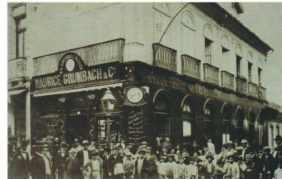
Fig.122 Sobrado de taipa de pilão pertencente a Maurice Grumbach, dono da joalheria e relojoaria de mesmo nome. Foto integrante da Revista Industrial , álbum elaborado por Jules Martin para representar o Estado de São Paulo na Exposição Universal de 1900, em Paris. Acervo Museu Paulista – USP.
