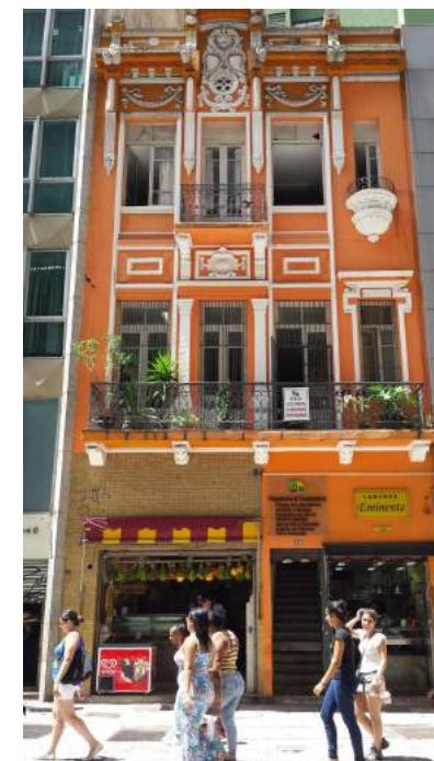
Fig.151 Edifício projetado por Julio Micheli para o advogado e capitalista Luiz de Oliveira Lins de Vasconcellos. De tijolo e uso misto, mesclava lojas no térreo, oficinas na sobreloja e salas nos andares superiores. Foto da autora, 2015.
