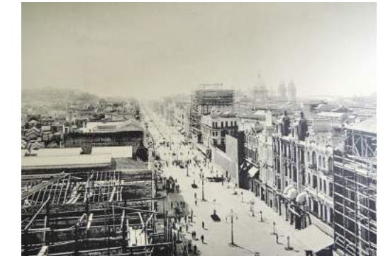
Fig.17 Avenida Central em obras. Foto de Marc Ferrez. In: FERREZ, Gilberto. O Álbum da Avenida Central. Um documento fotográfico da construção da Avenida Rio Branco, 1903-1906 .
