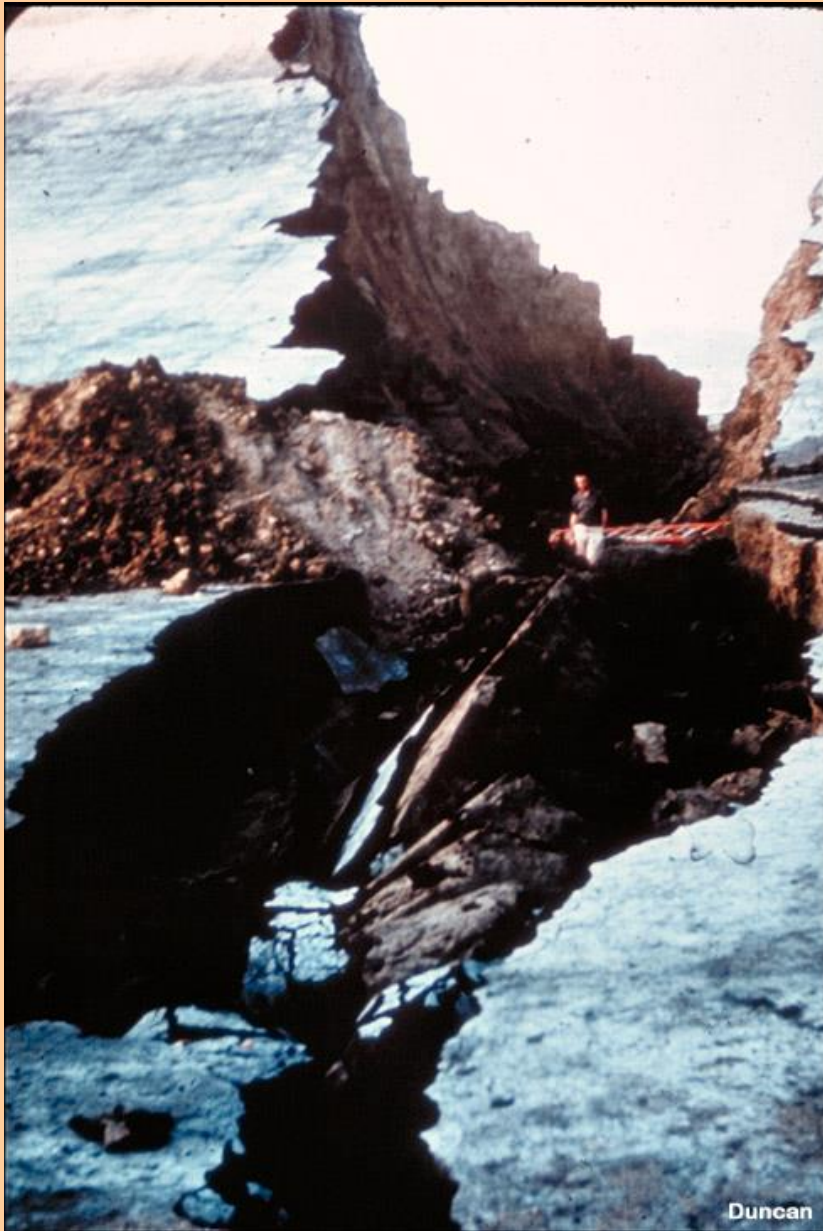
Barragem Baldwin Hills (rompeu em 1963 por “piping”)
