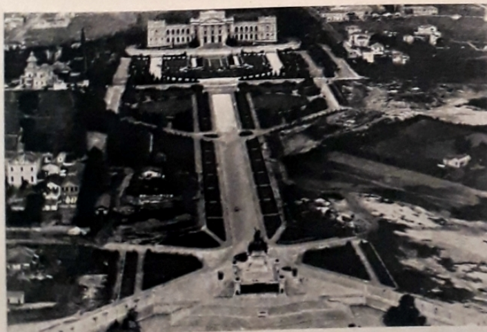
Fig. 25 — Parque da Avenida da Independência
