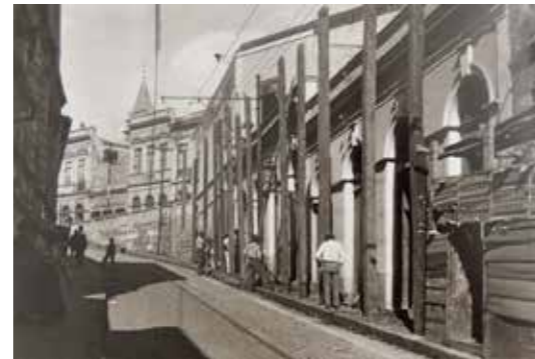
Fig.416 Casa de Empréstimos e Penhores de Luís Medici em demolição. Aurélio Becherini. Casa da Imagem.
