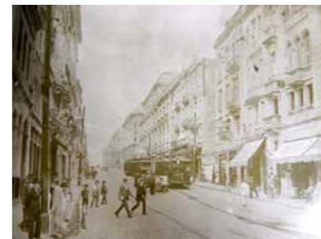
Fig.423 Rua Líbero Badaró, com destaque para a homogeneidade dos edifícios do lado ímpar. Acervo da Fundação da Energia e São Paulo.
