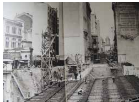
Fig.118 Em primeiro plano vê-se o Viaduto Boa Vista em obras em fins da década de 1920 e, em segundo plano o Condessa Siciliano já pronto (concluído em 1924) e, ao fundo, o Banco Commercial do Estado de São Paulo, com seu nome estampado na empena lateral. A foto revela sua inserção na quadra, com fachada tanto para a 15 de Novembro como para a rua Boa Vista. Acervo Siciliano & Silva. GONZALEZ et al., 2012, contracapa.
