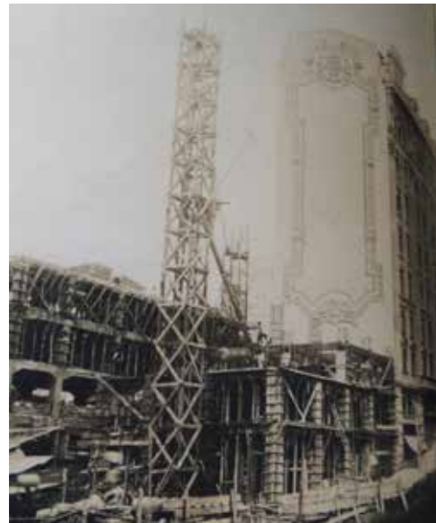
Fig.117 Em primeiro plano o canteiro de obras do edifício Condessa Siciliano (concluído em 1924), em segundo plano o Casa Palmares (concluído em 1922) e, ao fundo, o London & River Plate Bank com nome inscrito na empena lateral como o vizinho. Acervo Siciliano & Silva. GONZALEZ et al., 2012, p.122-123.
