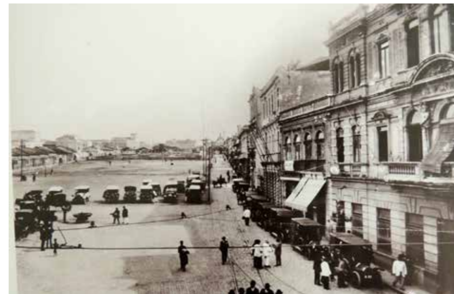
Fig.444 Foto da Praça da Sé após a demolição dos dois quarteirões. Ao fundo vê-se a Igreja de São Gonçalo e à esquerda as casinhas térreas do alinhamento da desaparecida Rua Capitão Salomão. Acervo do DPH, Prefeitura Municipal.
