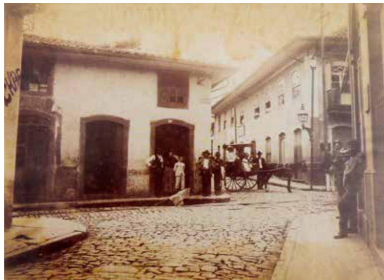
Fig.408 Foto de Afonso de Freitas mostrando os casarões demolidos de acordo com a Lei nº. 913 de 9 de junho de 1906. LEMOS, 2001.
