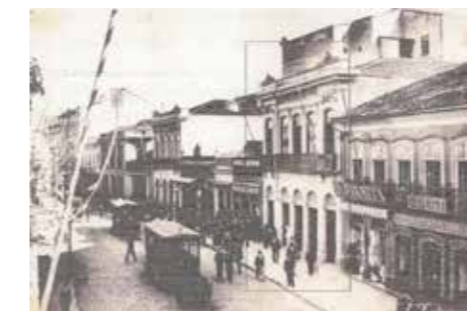
Fig.88 Foto da Light de 1901, com destaque para o Banco Comercial Ítalo Brasileiro instalado no antigo sobrado de D. Anna Rosa de Araújo. Acervo da Fundação Patrimônio Histórico da Energia de São Paulo.
