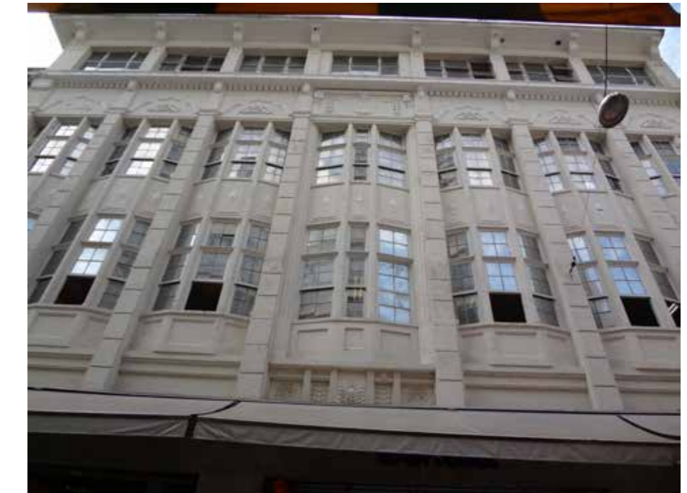
Fig.222 Casa Alemã hoje, conforme reforma de Carlos Ekman em 1910. Foto da autora, 2015.
