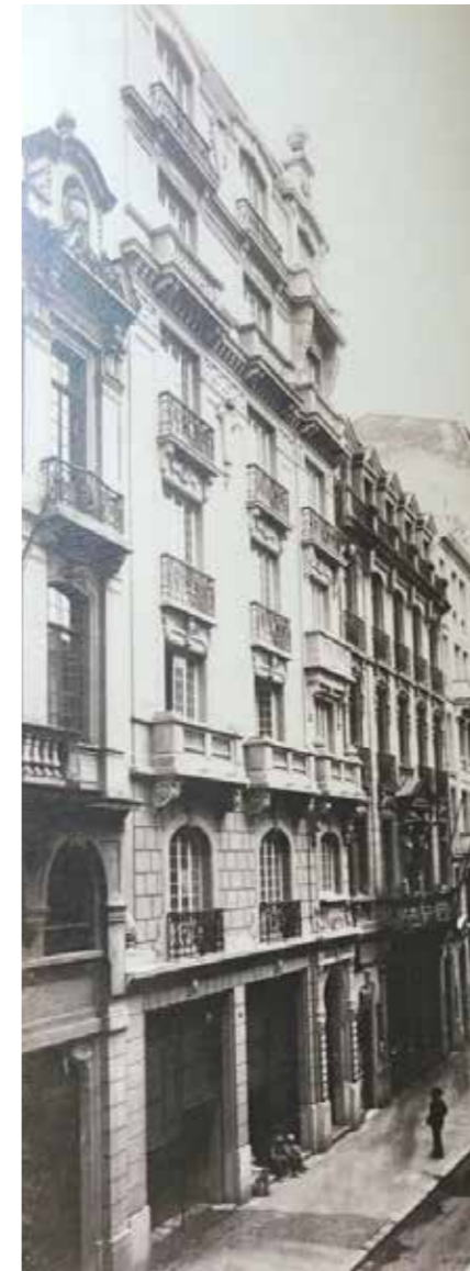
Fig.425 Edifício Stella Penteadado (34m), projetado por Siciliano & Silva na década de 1920, respeitando as linhas mestras dos contíguos, mas rompendo o gabarito com o ático elevado. Vê-se que o lado par da Líbero Badaró, não desapropriado, tem feição mais heterogênea que o lado ímpar. GONZALEZ & NOVAES, 2012.
