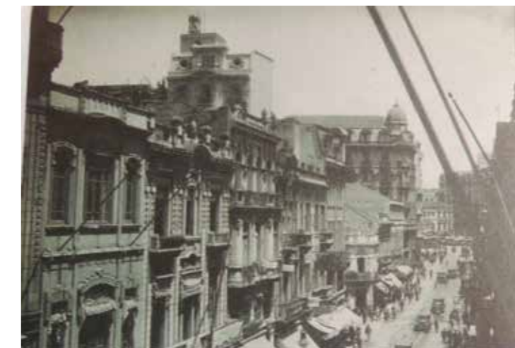
Fig.158 Aspecto do final da quadra 6 em 1929, vendo-se a sequência de elegantes edificações projetadas em 1909. Arquivo IEB-USP.
