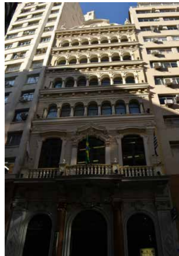
Fig.134 Banco Português do Brasil, 1919, Rua 15 de Novembro n. 194, F. P. Ramos de Azevedo & Cia Engenheiros Architectos. Foto da autora, 2015.
