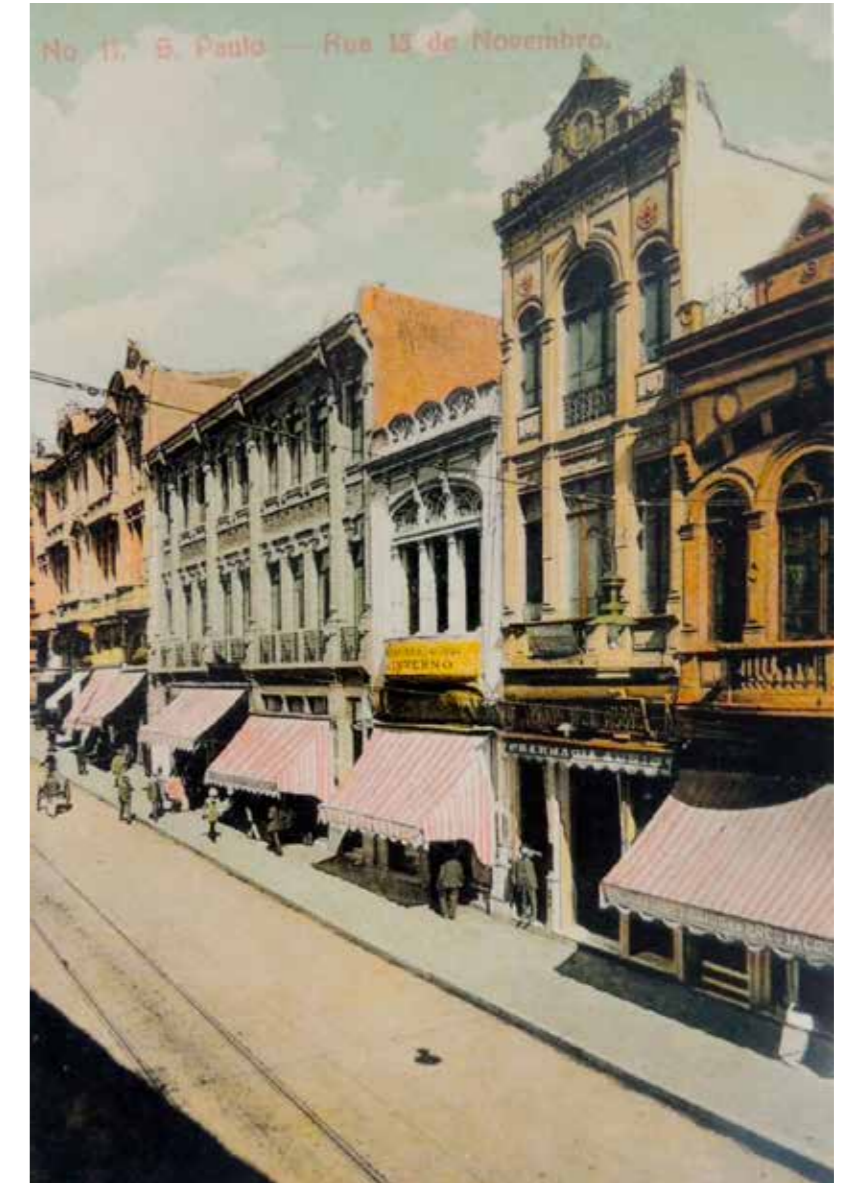
Fig.331 Rua 15 de Novembro por volta de 1911. Em primeiro plano, mais alto à direita, vê-se o prédio pertencente a José Patrício Fernandes, que abrigava sua loja Camisaria Colombo (lote 30A) (n. neutro 59), cujo projeto exibimos na Fig.137 (AHSP – OP 1915 – 003.125). O imóvel foi demolido para dar ensejo ao Banco Português . Em verde, destaca-se a fachada longa da Cia. Mecânica Importadora e ao seu lado o Restaurante Progredior e a Livraria Garraux (n. neutro 53), único imóvel sobrevivente ao lado do Banco Alemão . Cartão-postal colorizado. Acervo do Museu Paulista – USP.
