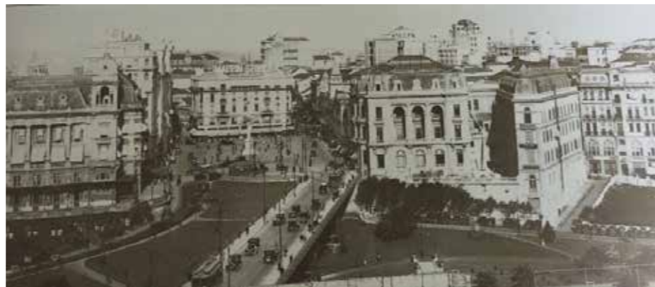
Fig.430 A Praça do Patriarca concluída em 1926, em diálogo com os Palacetes Prates construídos em 1914. TOLEDO, 1989.
