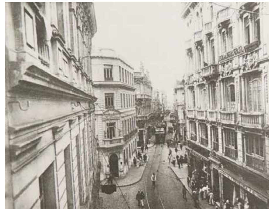
Fig.410 Palacete Carvalho , de cinco pavimentos, foi construído em 1911 e está à direita nesta foto de Guilherme Gaensly de 1916. À esquerda, vemos o prédio da Farmácia Amarante , também alteado. Ao fundo vê-se o prédio das Indústrias Reunidas Matarazzo , sequenciado pelo Palacete Lara . Acervo Casa da Imagem.
