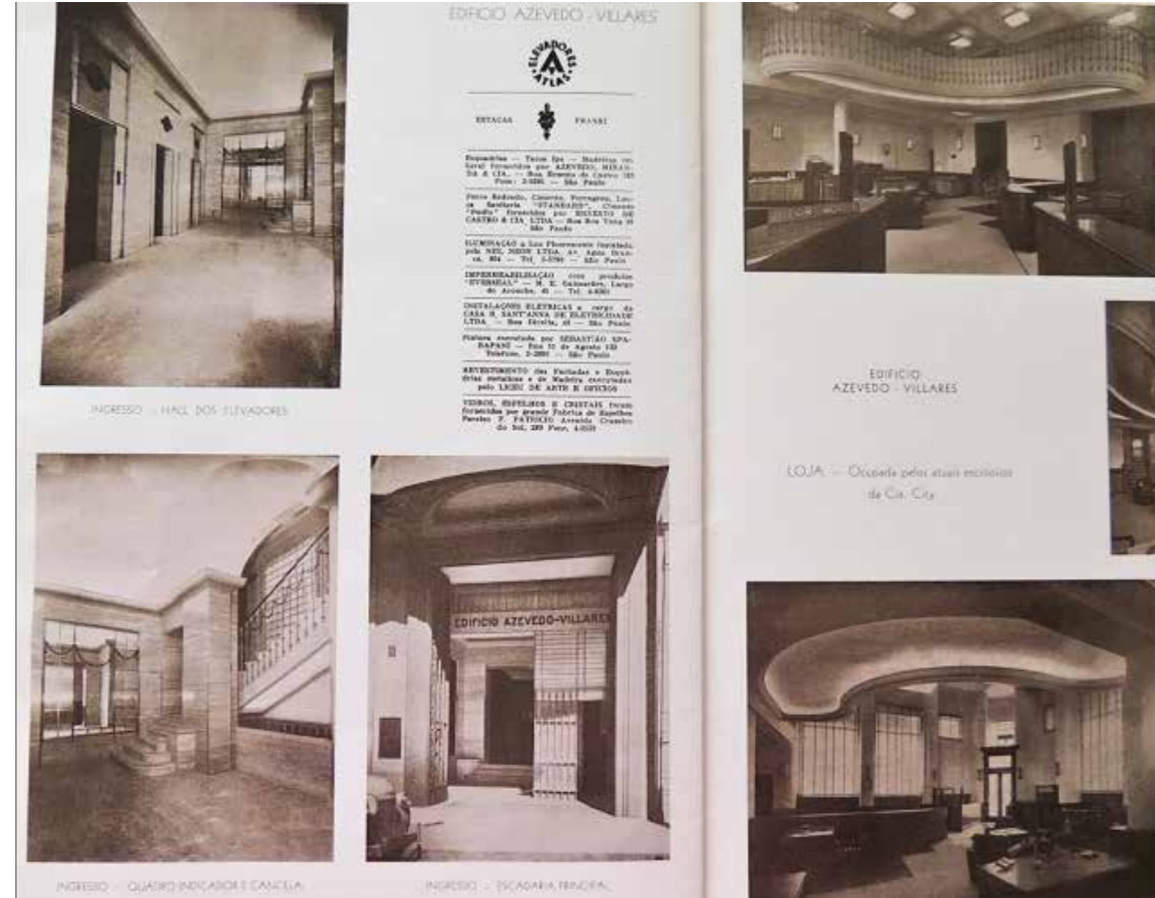
Fig.392 Interior do Edifício Azevedo-Villares, com destaque para a qualidade dos materiais utilizados. Serralheria artística, mobiliário e acabamentos foram realizados pelo Liceu de Artes e Ofícios .
