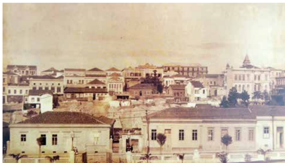
Fig.412 Casas de aluguel do Conde Prates na Rua Formosa, demolidas para possibilitar a instalação do parque, segundo a Lei nº. 1457 de 9 de setembro de 1911. Foto de Afonso de Freitas. LEMOS, 2001, p.129.
