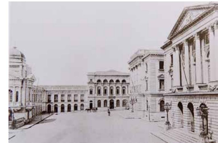
Fig.389 Conjunto de secretarias do Pátio do Colégio. Casa da Imagem.
