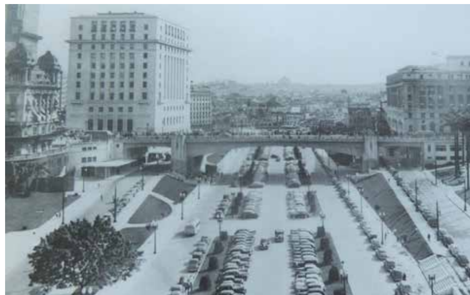
Fig.459 Conde Matarazzo pronto e ao fundo o Edifício da Cia. Paulista de Seguros em construção, apequenando o Palacete Prates, e insinuando o padrão que vigoraria a partir dos anos 1940. Acervo FAUUSP.
