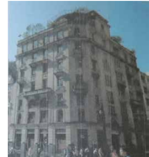
Fig.441 Casa Dhelomme , fachada para Rua Líbero Badaró. Projeto da Cia. Iniciadora Predial , 1920. AHSP - SOP - Caixa S7, 1920. SANTOS, 2017, p.232-324.
