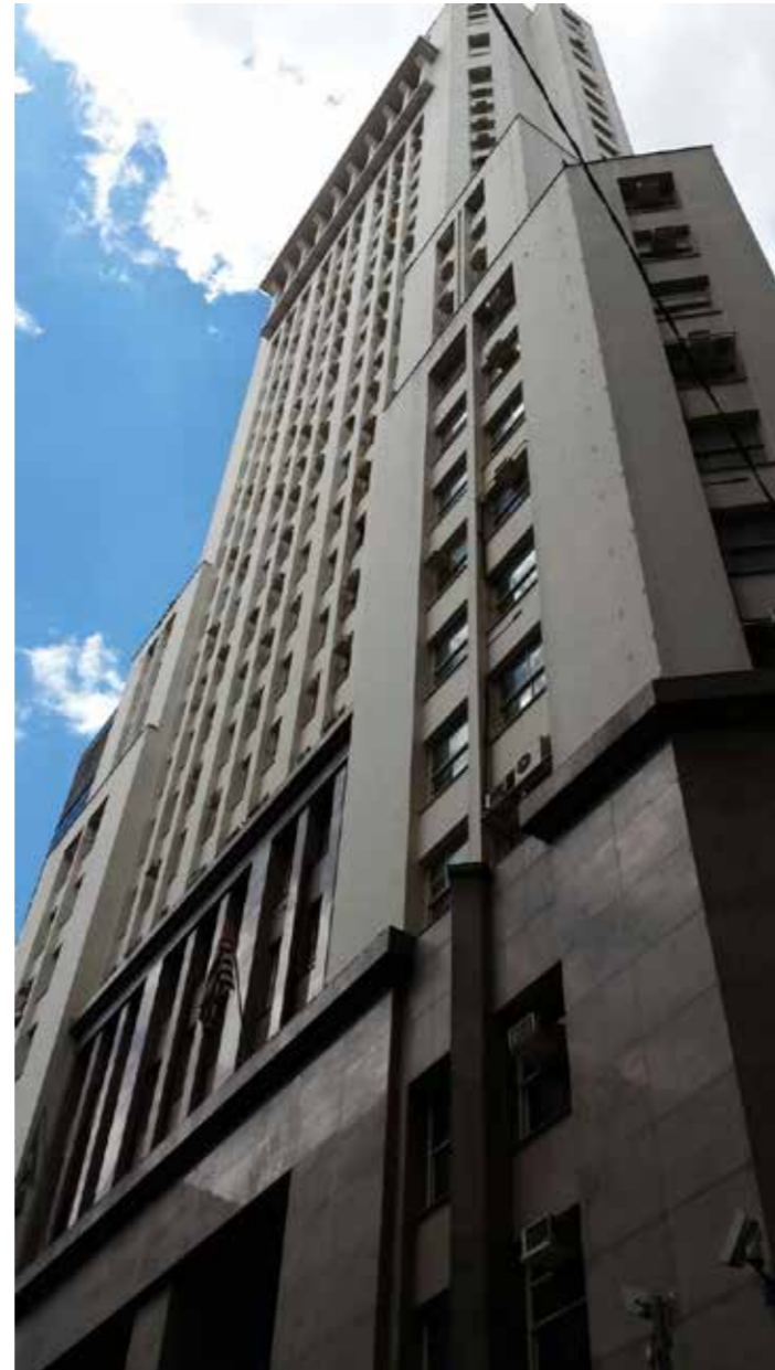
Fig.109 Banespa, 1939-1946, projeto de Plínio Botelho do Amaral e construção de Camargo e Mesquita. Foto da autora, 2015.
