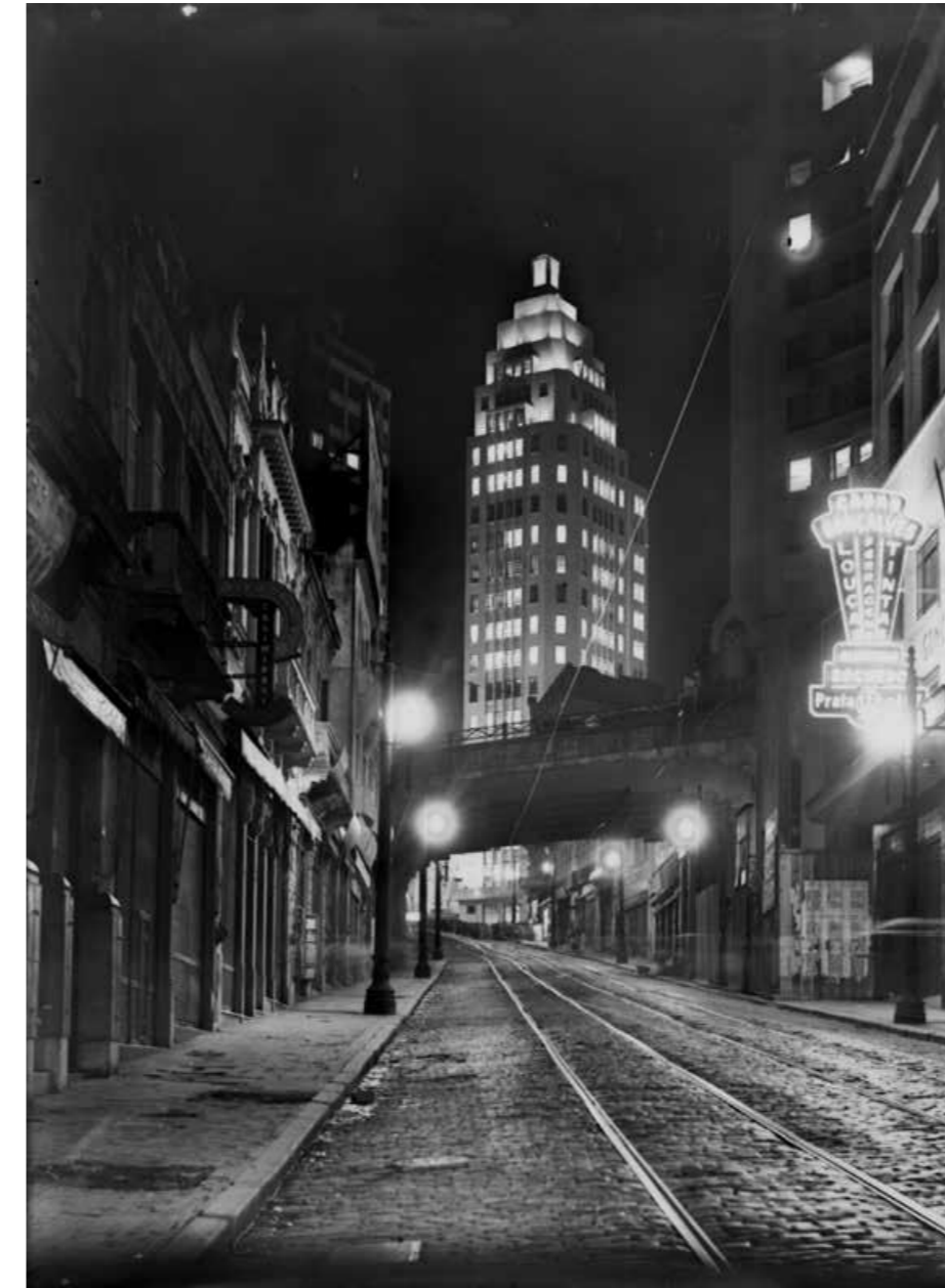
Fig.447 Edifício Azevedo Villares iluminado à noite. Acervo FAUUSP.
