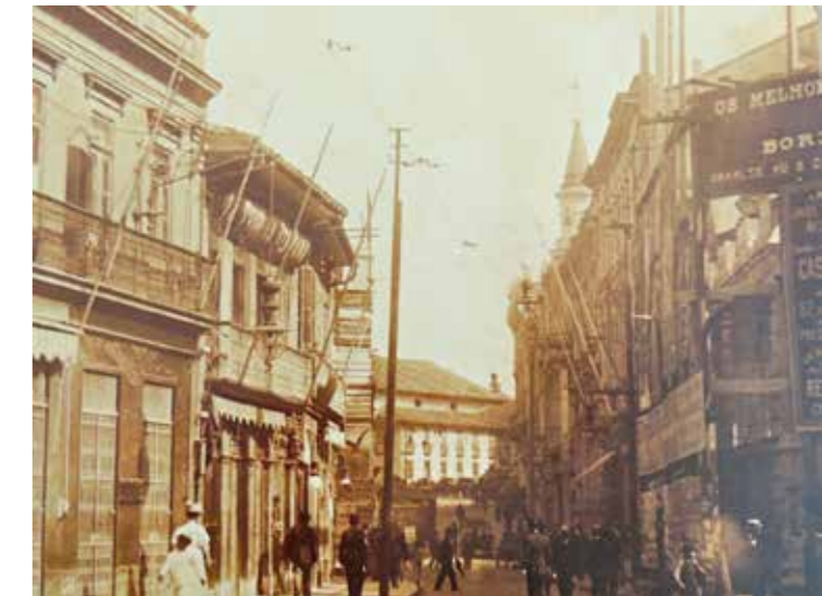
Fig.403 Rua 15 de Novembro, 1912-1914, em processo de realinhamento. Em primeiro plano à esquerda, vê-se o Café Americano ladeado pela Confeitaria Nagel. Do lado direito, destaca-se o torreão do Palacete Paiva no largo do Tesouro e a antiga Sé ao fundo. Na esquina, o London & Brazilian Bank, em obras. Foto de Afonso de Freitas. LEMOS, 2001, p.51.
