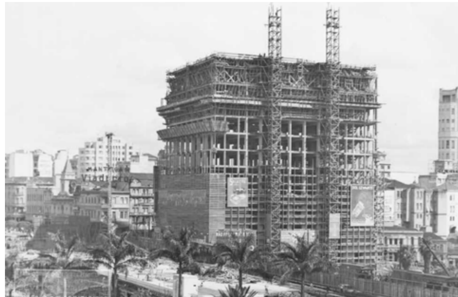
Fig.458 Edifício Conde Matarazzo em obras, 1937. Acervo FAUUSP.
