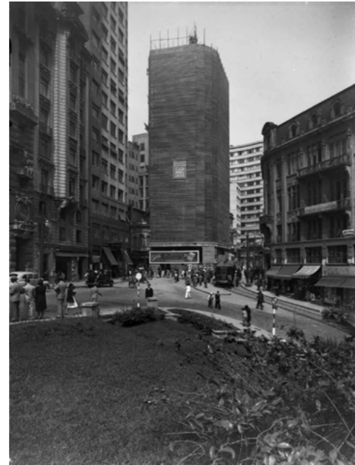
Fig.446 Edifício Azevedo Villares em obras, com tapumes, sito à rua Quinze de Novembro com Largo do Tesouro. Acervo FAUUSP.
