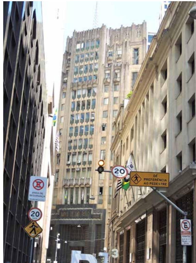
Fig.106 Banco de São Paulo , projetado por Álvaro de Arruda Botelho, em 1935-1936. Perspectiva da Ladeira Porto Geral. Foto da autora, 2015.
