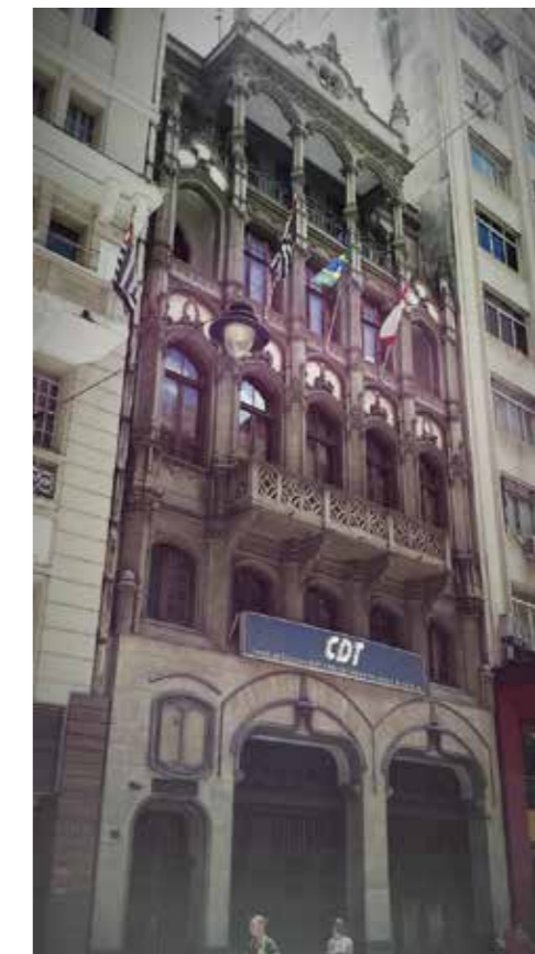
Fig.95 Edifício Fakhoury, rua 15 de Novembro, n.251, encomendado por José Fakhoury, em 1913, para F. P. Ramos de Azevedo & Cia. Concreto e tijolo e acabamentos do Liceu de Artes e Ofícios.
