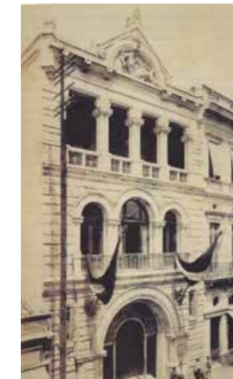
Fig.128 Banco Alemão antes da ampliação. Na foto de 1900 vê-se o imóvel térreo incorporado ao projeto de ampliação e, do lado oposto, a Casa Garraux. Acervo do Museu Paulista-USP.
