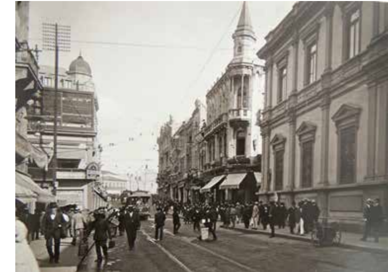
Fig.402 Rua 15 de Novembro, 1912-1914, em processo de realinhamento iniciado em 1901. Observe que o realinhamento se deu no lado par (à esquerda). À direita vê-se o prédio do Tesouro Provincial e o Palacete Paiva construído em 1905. Foto de Aurélio Becherini. Casa da Imagem.
