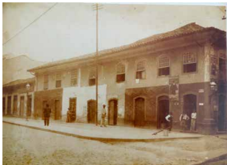
Fig.409 Foto de Afonso de Freitas, tirada em março de 1908, da rua Quintino Bocaiuva esquina com José Bonifácio, mostrando os casarões que seriam demolidos de acordo com a Lei nº. 913 de 9 de junho de 1906. LEMOS, 2001.
