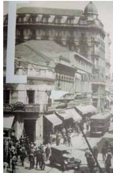
Fig.160 Aspecto da quadra Z em 1929. Ao fundo, pertencente à quadra 8, destaca-se o prédio Previdência Caixa Paulista de Pensões, com letreiro na fachada. Arquivo IEB-USP.
