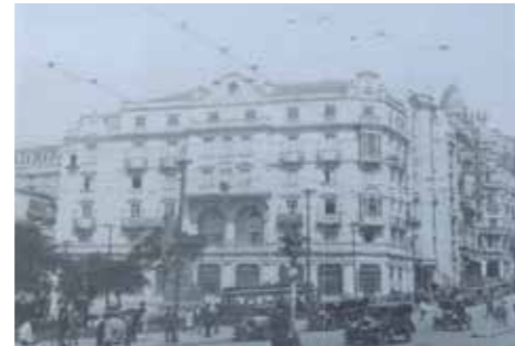
Fig.435 O conjunto de edifícios do lado direito da Avenida São João visto de outro ângulo. No primeiro plano está o neocolonial Edifício Baraúna (1923), projetado por Ricardo Severo no escritório F. P. Ramos de Azevedo & Cia. , ladeado pelos dois prédios para Daniel Dhelomme. (SANTOS, 2017, p.232-324).
