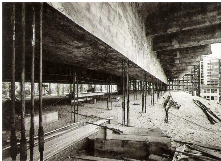
Laje nervurada na cota 8,40 m suspensa por tirantes
