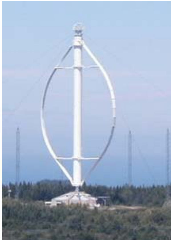
Turbina Darrieus 3.800 kW (Canadá, 1984)
