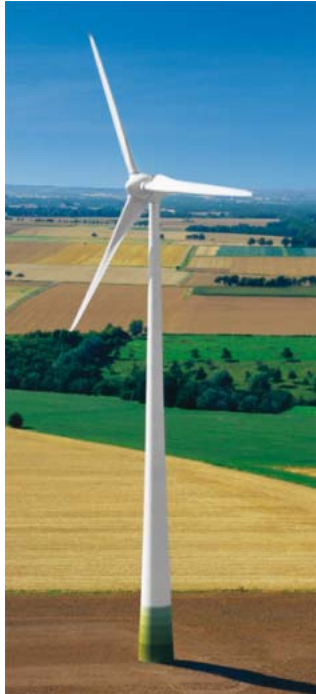
Turbina eólica de 2.300 kW da Enercon
