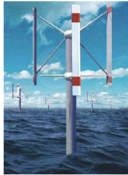
Turbina idealizada Darrieus subtipo H-rotor de 3.000 a 10.000 kW (VertAx Wind Ltd. - Inglaterra, 2009)
