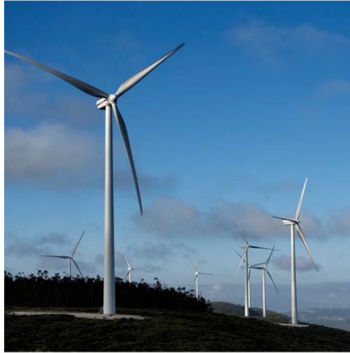
Fazenda eólica com turbinas de 3.000 kW da Vestas
