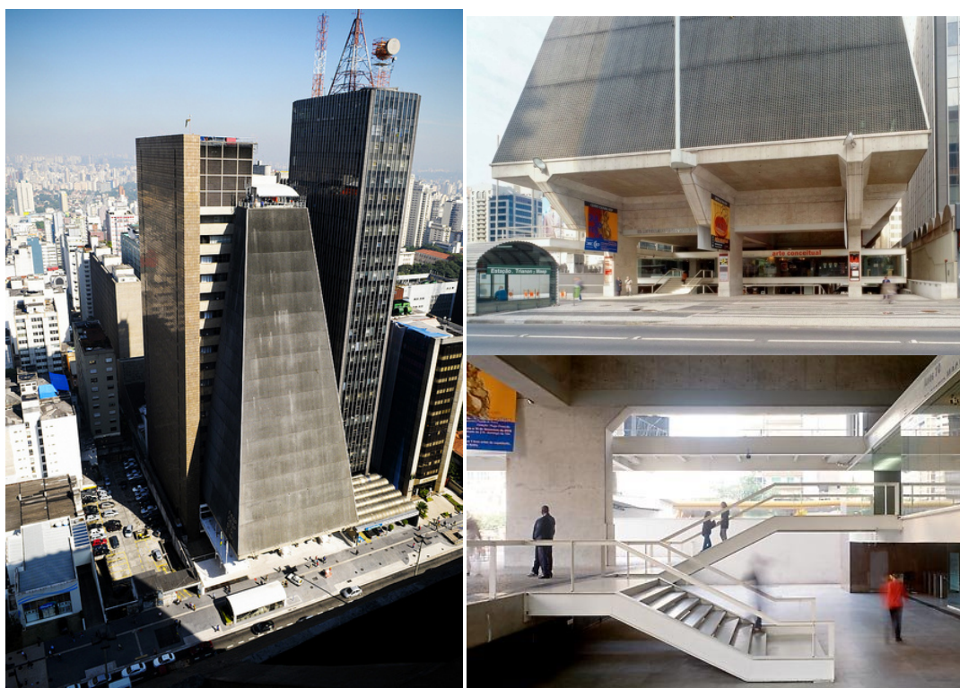
Figura 2 – Imagem da direita, o edifício da FIESP; imagem da esquerda e acima, a frente deste mesmo edifício; imagem esquerda e abaixo, o acesso aos pisos térreo superior e inferior, onde ocorrem os principais eventos culturais.
