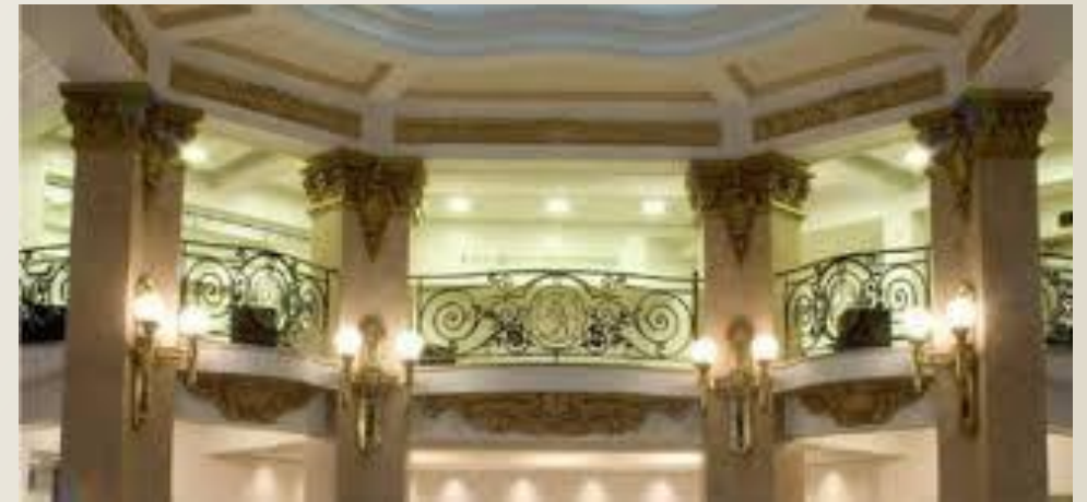
Coluna e Vigas
