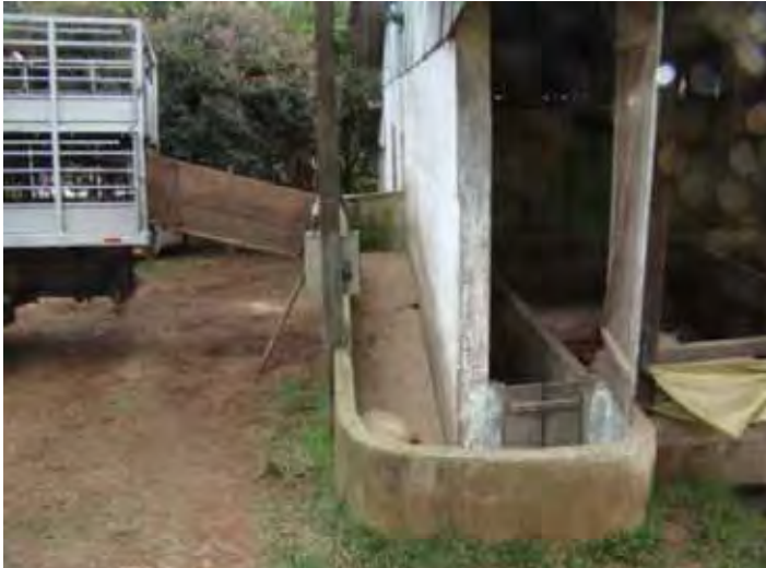
Figura 14. Corredores com curva inadequada para condução dos animais
