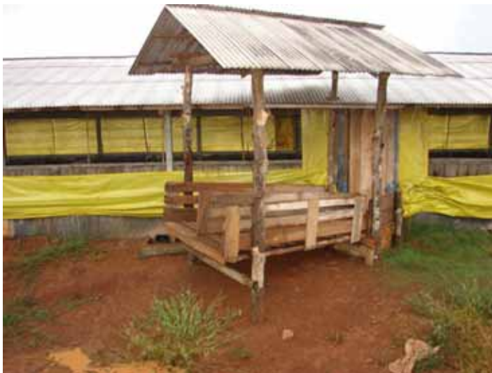
Figura 16. Embarcadouro com paredes laterais vazadas dificulta a condução
