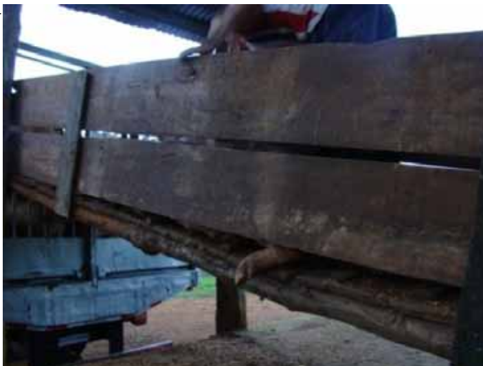
Figura 18. Embarcadouro com piso instável e com laterais abertas que aumentam o risco de lesões nos suínos
