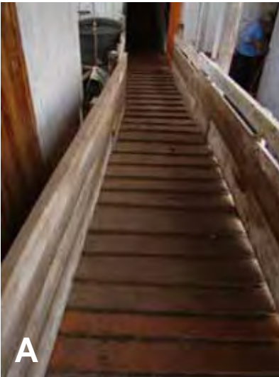
Figura 17. Vista interna do embarcadouro: piso antiderrapante (A) e piso liso (B)
